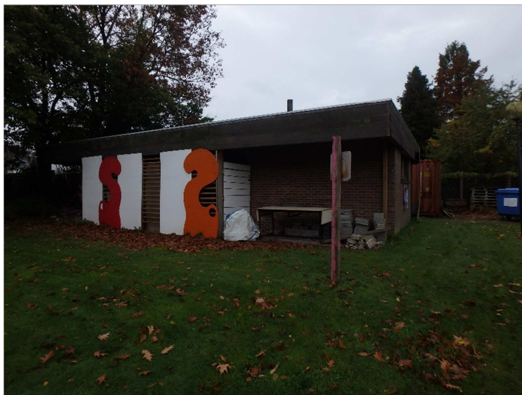
Figuur 43: Gebouwtje aan de Larestraat (ARCHEBO bvba, 24/10/2017)
