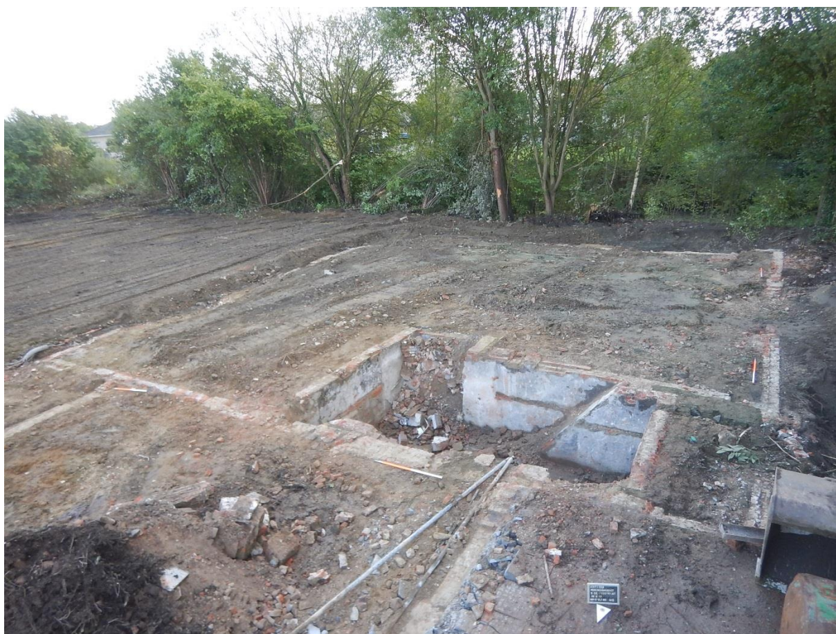
Figuur 39: Overzichtsfoto van de bij de werfbegeleiding vrijgelegde buitenmuur (M1) en kelder (M5) van de oudste vastgestelde fase van het Withof
