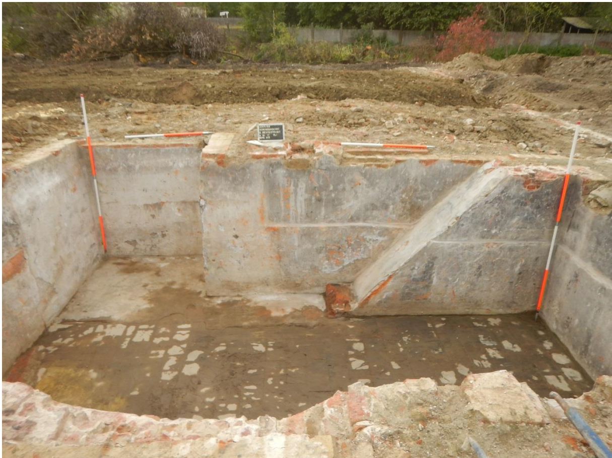
Figuur 42: Kelder (M5) binnen oudste vastgestelde gebouwvleugel (M1)
