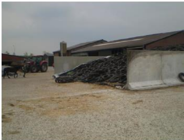
Figuur 13: Foto bestaande betonverharding met twee betonwanden. 14
