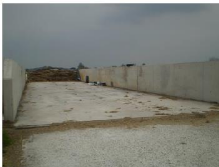
Figuur 14: Foto bestaande betonverharding met twee betonwanden. 15
