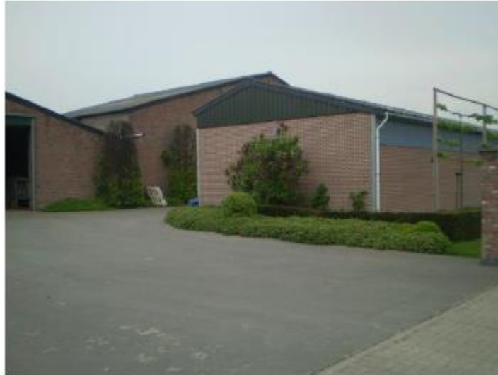
Figuur 7: Foto bestaande jongveestal (rechts; 990m 2 + 981.2m 2 ) en rundveestal (links; 192m 2 ). 8
