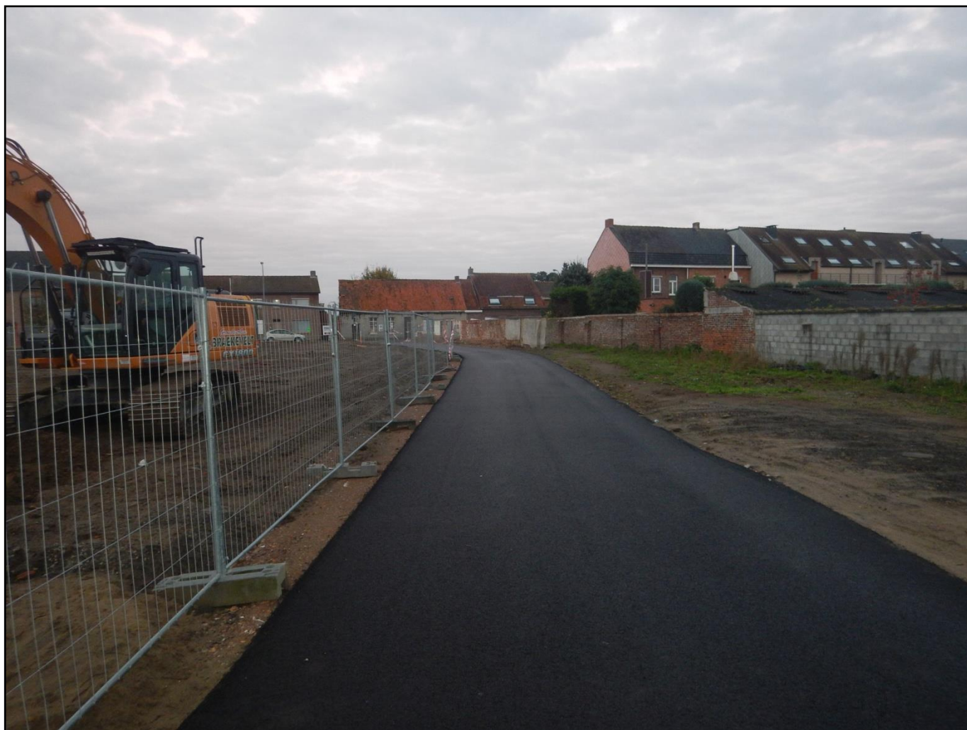
Figuur 5. Nieuw aangelegd weg ter hoogte van de noordwestelijke sleuf.
