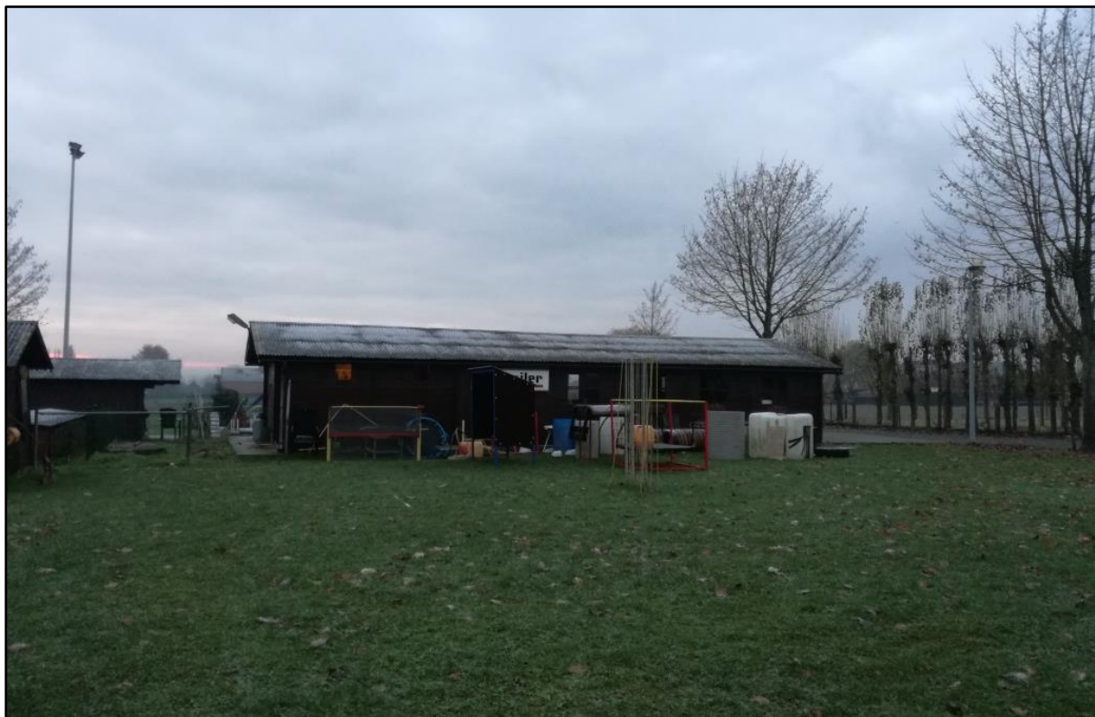
Figuur 3 Zicht op de aanwezige hondenschool in houtskeletbouw.
