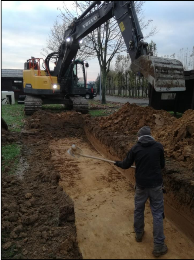
Figuur 10 Sfeerbeeld tijdens de aanleg van de proefsleuven.
