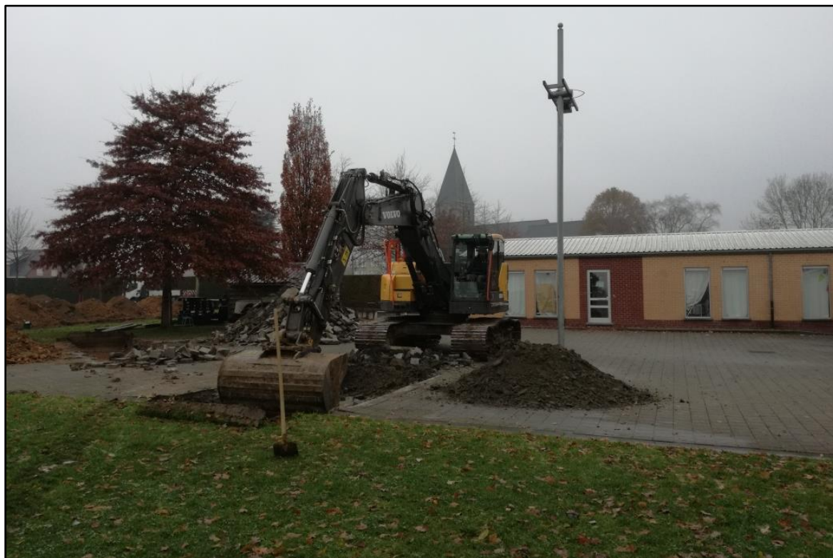
Figuur 8 Aanleg van de sleuven ter hoogte van de koer met betonklinkers.
