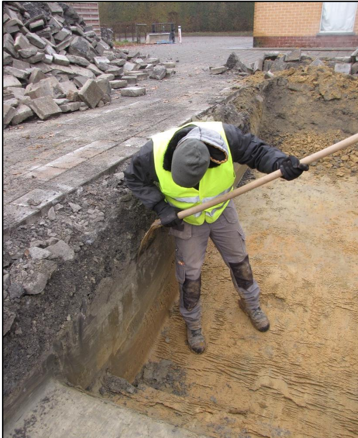
Figuur 9 Plaatsen van een profiel.
