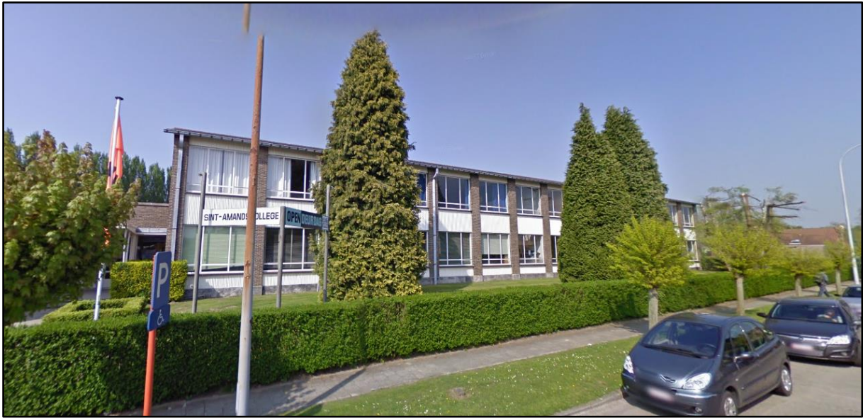
Figuur 2 Zicht op de zuidelijke vleugel van het schoolgebouw (bron: google maps).
