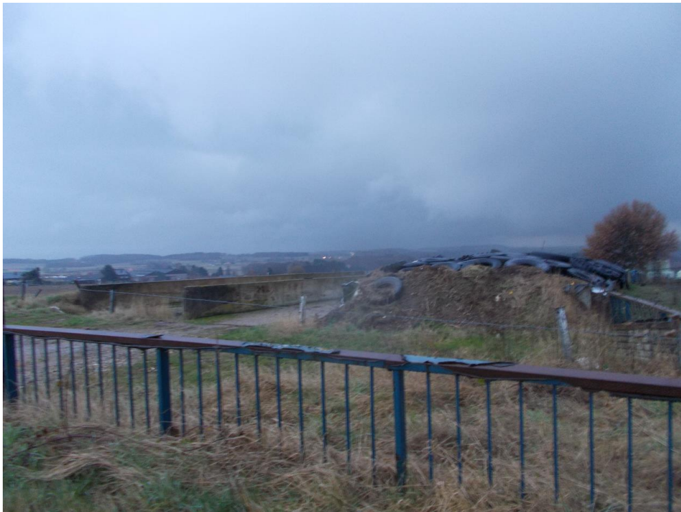
Figuur 6: Steenslagverharding en sleufsielo. 10
