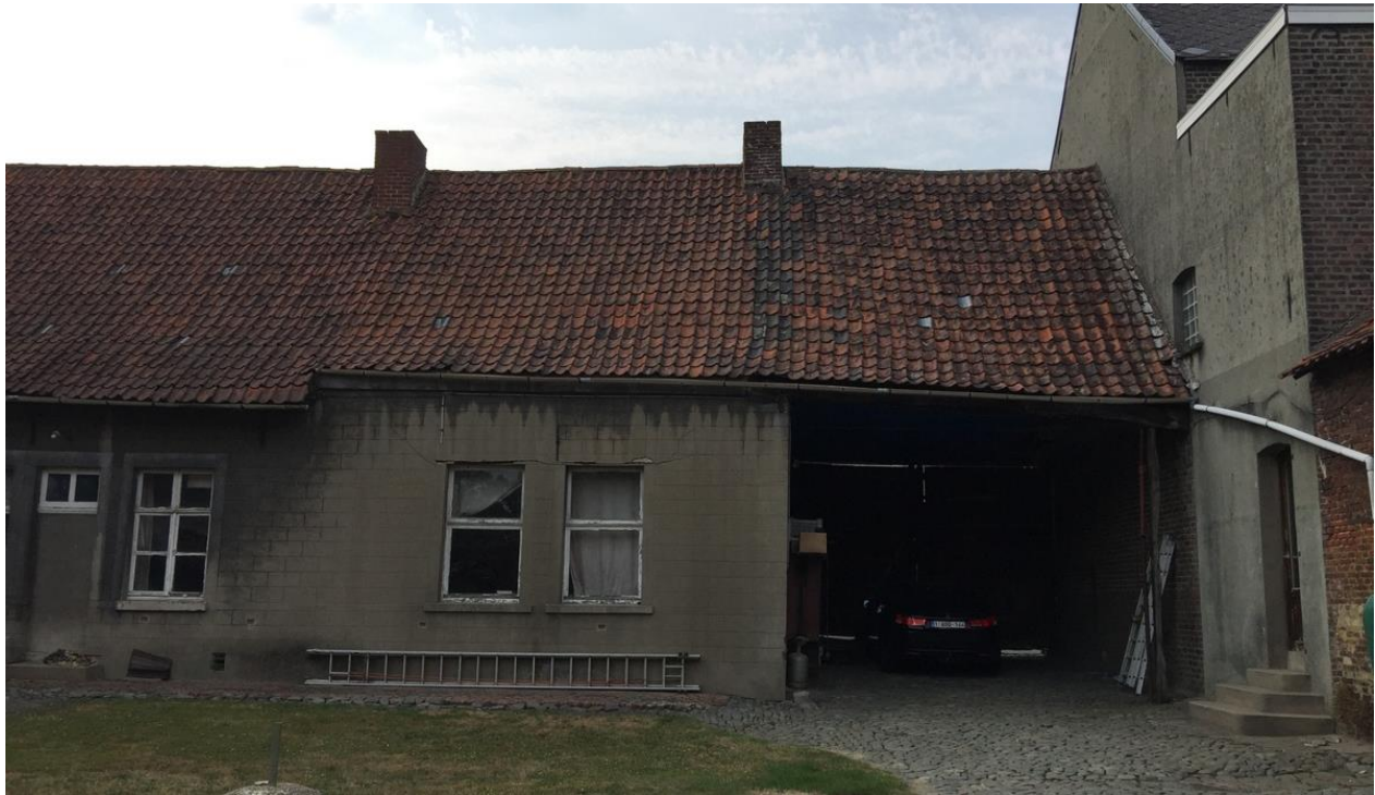
Figuur 6: zicht op het boerenhuis en inrijpoort vanaf het erf
