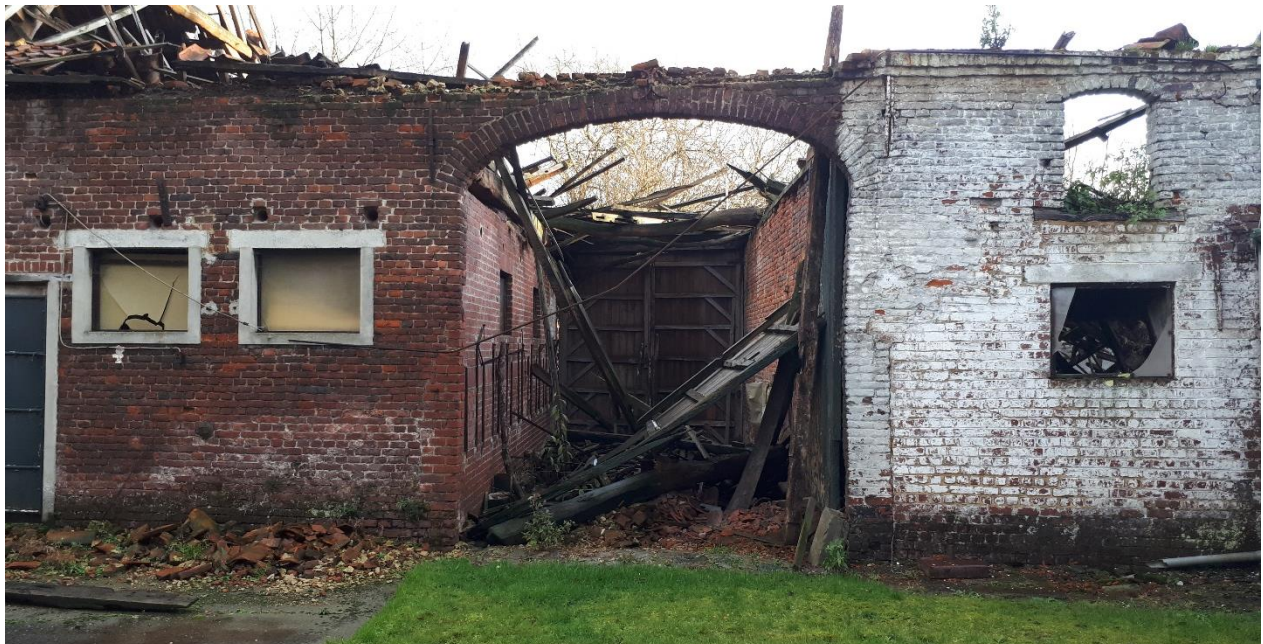
Figuur 16: 19 de eeuwse metselwerk met typische gevelankers en spaarboogconstructie in doorgang naar achtererf (zuidvleugel)
