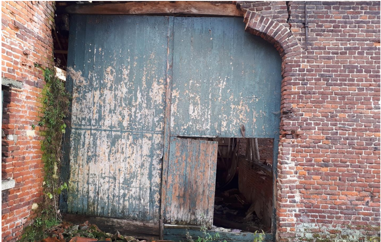
Figuur 15: 19 de eeuwse metselwerk met typische gevelankers en spaarboogconstructie boven toegangspoort schuur (zuidvleugel)
