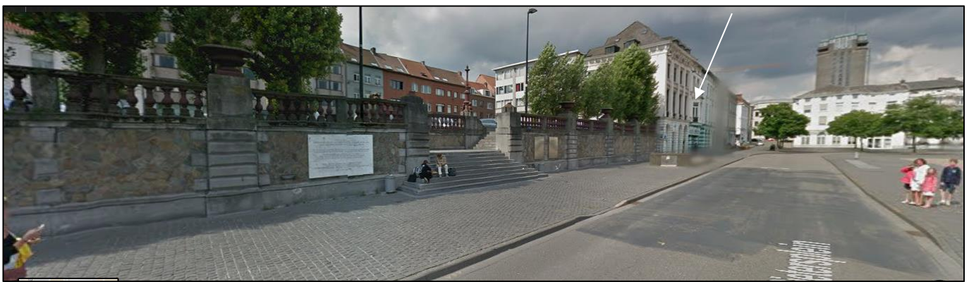
Figuur 38. Monumentale trappenpartij die de verbinding vormt tussen het Sint-Pietersplein en het hoger gelegen Sint-Amandplein, met aanduiding van het projectgebied (©google maps).
