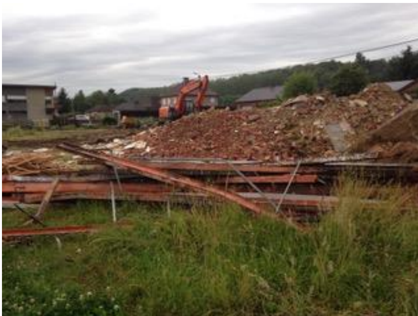
Figuur 6: Afbraakwerken op het terrein in 2014 (Bron: Odette van Brusselen, 2017).
