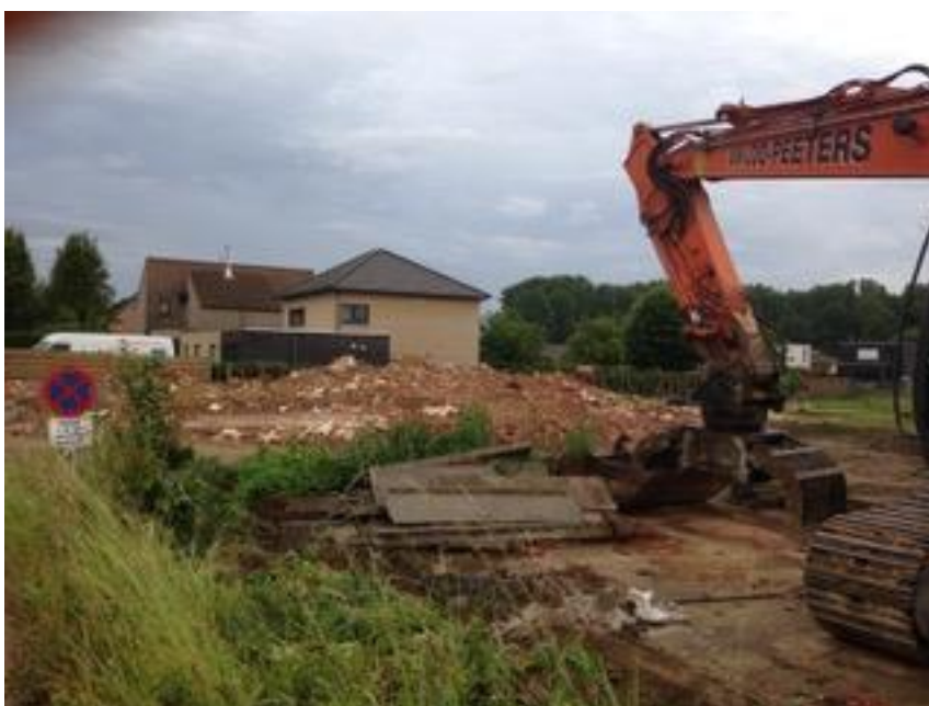
Figuur 7: Afbraakwerken op het terrein in 2014 (Bron: Odette van Brusselen, 2017).
