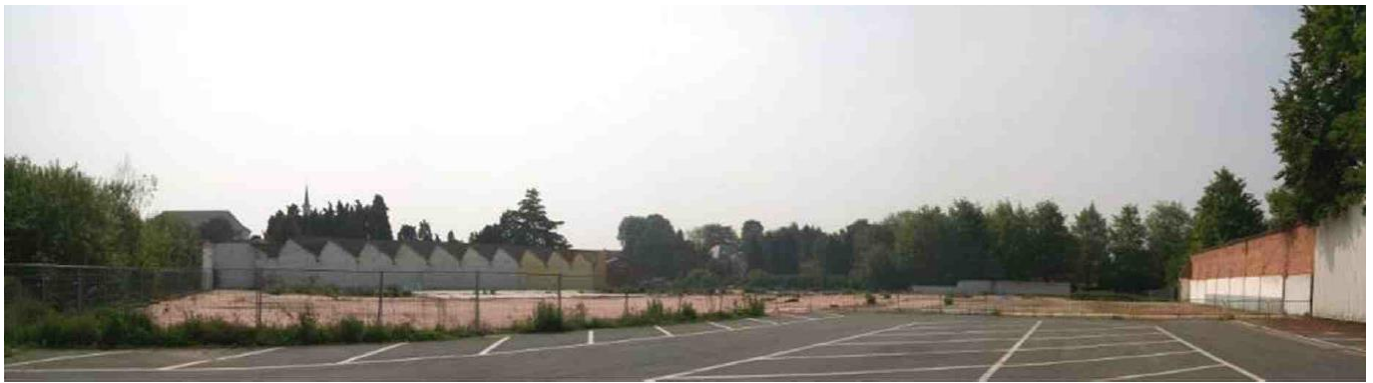
Figuur 24: Gesloopte bedrijfsgebouwen op de site Van Damme. Links de fabriekswand als scheiding met de kloostertuint Arme Klaren, rechts de fabriekmuur ter hoogte van een speelterrein. (Bron: RUP).
