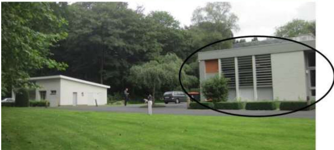
Figuur 5: zicht op het af te breken keukenvolume, getrokken vanuit het zuiden (boven) en het noorden (onder) van het terrein. Let ook op de al aanwezige verharding. (eigen opname, dd 07/2016)
