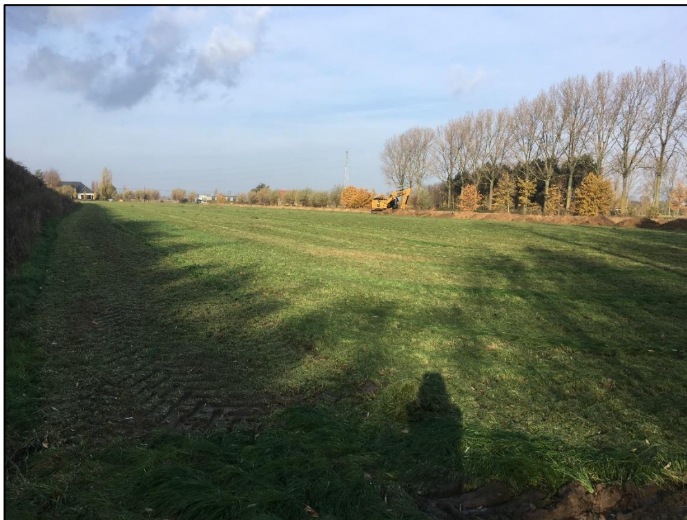
Foto 3: Overzicht vanuit de zuidoostelijke hoek van het terrein tijdens de aanleg van de tweede sleuf.
