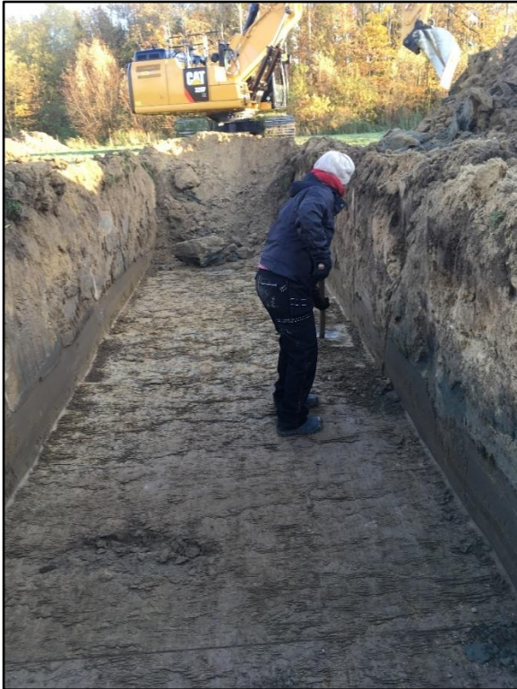
Foto 5: Opschonen van de sleuf (sleuf 3)
