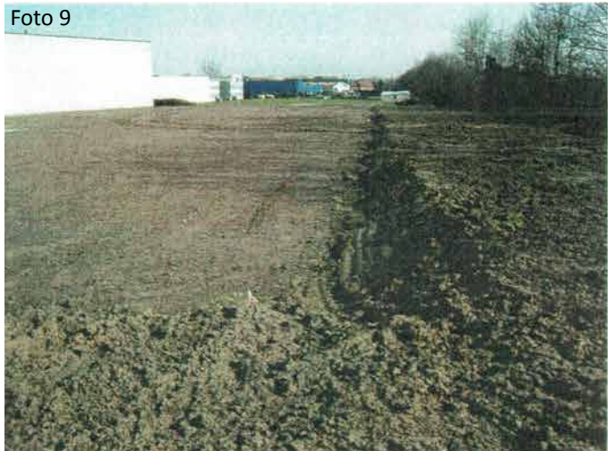
Figuur 9: Tijdens de werken in 2007 werd het zuidwestelijk deel van het terrein genivelleerd voor de aanbouw en opgehoogd langs de E40
