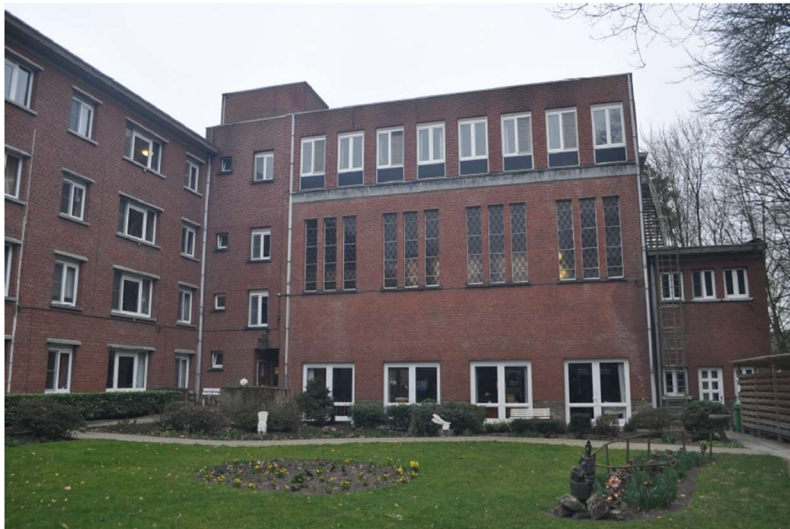
Figuur 3d. Zicht op de zijbeuk van het rusthuis voorafgaand aan de sloop (uit dossier stedenbouwkundige vergunningsaanvraag 'gedeeltelijk slopen van een rusthuis').
