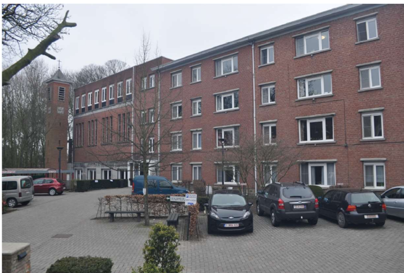
Figuur 3c. Zicht op het rusthuis voorafgaand aan de sloop (uit dossier stedenbouwkundige vergunningsaanvraag 'gedeeltelijk slopen van een rusthuis').
