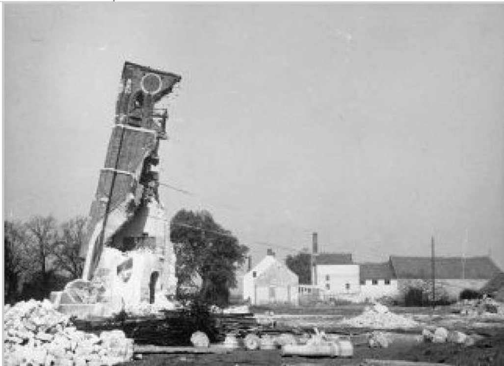
Figuur 68: Oorderen, sloop van de kerk 56
