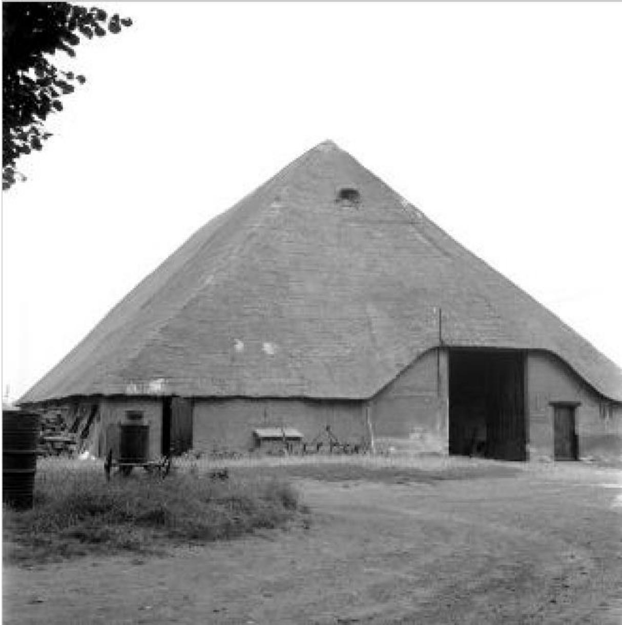
Figuur 52: Berghoeve, Grote Schuur in situ 43
