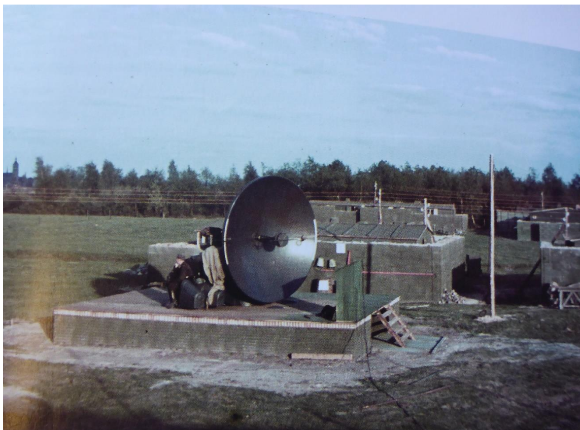
Figuur 62: Flak-stelling Oorderen, radar
