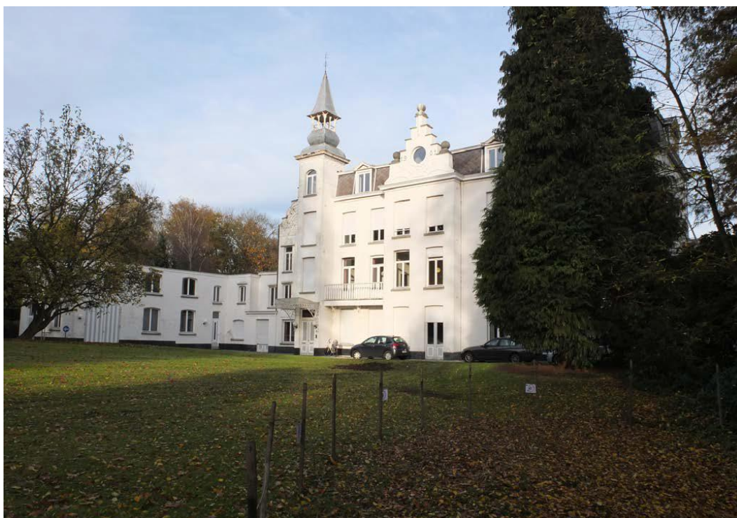
Afb. 4. Foto van het landhuis Vijverhof – huidige toestand.
