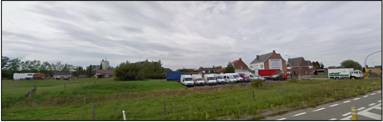
Figuur 5 Zicht vanuit het zuidoosten op de bebouwing, autostockageplaats en grasveldje in de oostelijke zone (bron: https://www.google.be/maps ).
