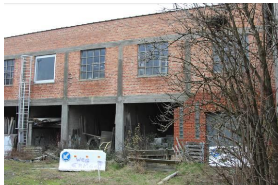
Fig. 57: Het L-vormig gebouw (© Kristine Magerman, Agilas vzw).
