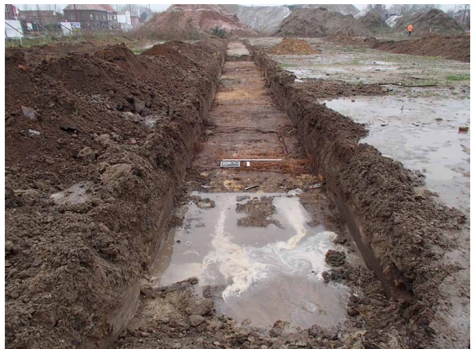
Figuur 18: Overzicht op proefsleuf 0002 vanuit het zuiden
