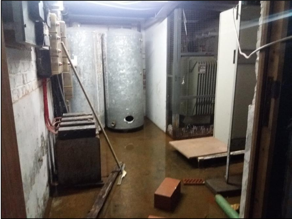
Figuur 5: Huidige situatie kelder
