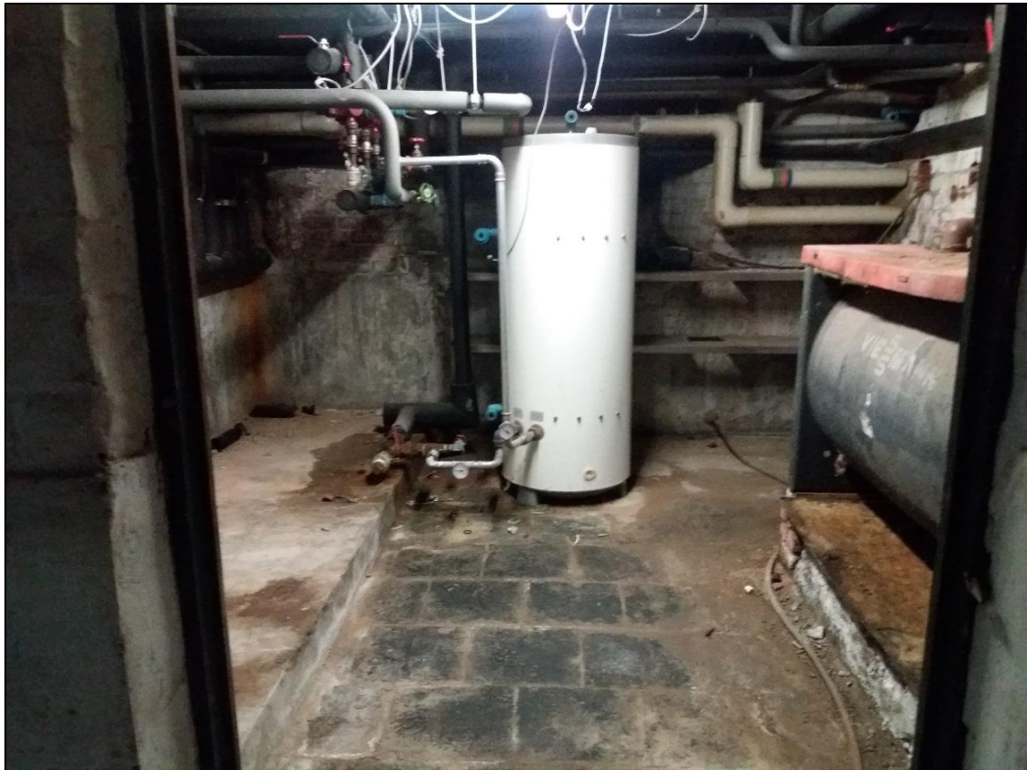
Figuur 70: Foto van de kelder van het te slopen gebouw tijdens een terreinbezoek
