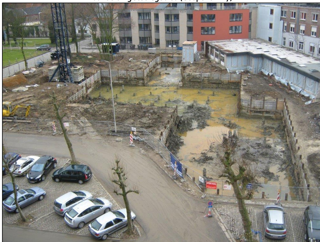
Figuur 63: Foto van he terrein tijdens de bouw van de kinderopvang tussen 2008-2011. In de rechterbovenhoek is het onderkelderde gebouw zichtbaar dat gesloopt zal worden (opdrachtgever 2017)
