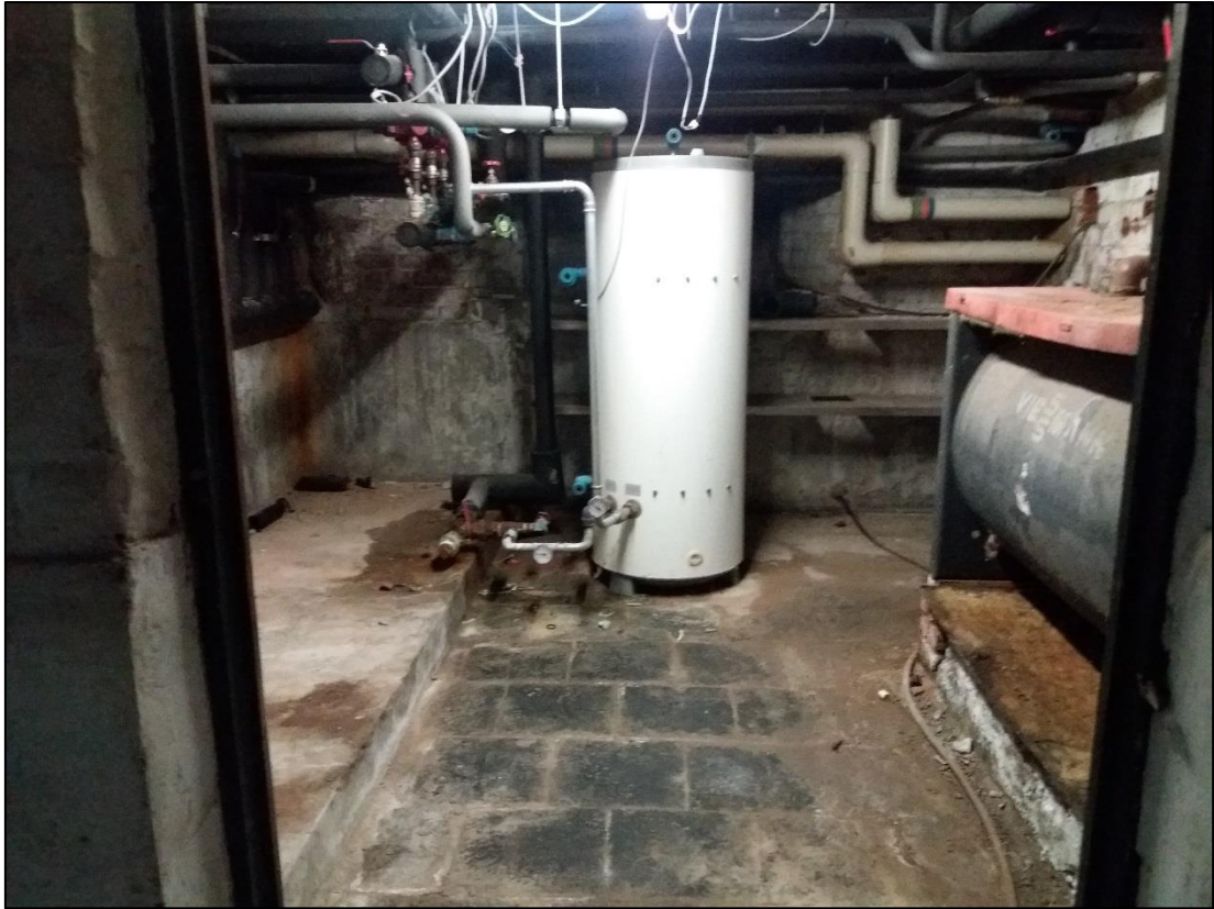
Figuur 11: Foto van de kelder van het te slopen gebouw tijdens een terreinbezoek
