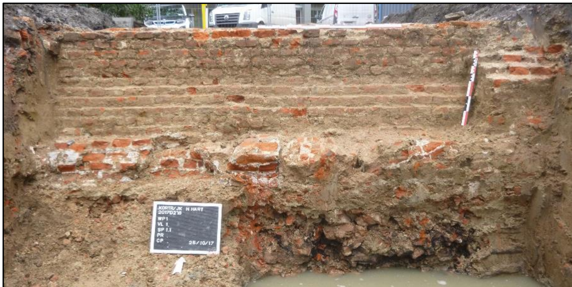
Figuur 86: Zuidzijde van muur spoor 1.1
