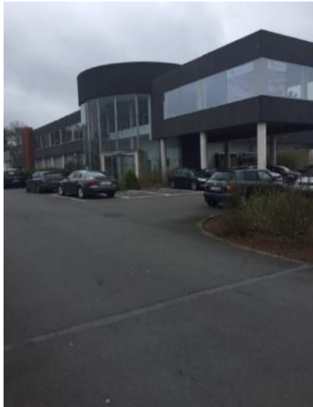
Figuur 1: Terreinfoto met het reeds bestaande gebouw gezien vanaf de Groendreef (opdrachtgever 2017).
