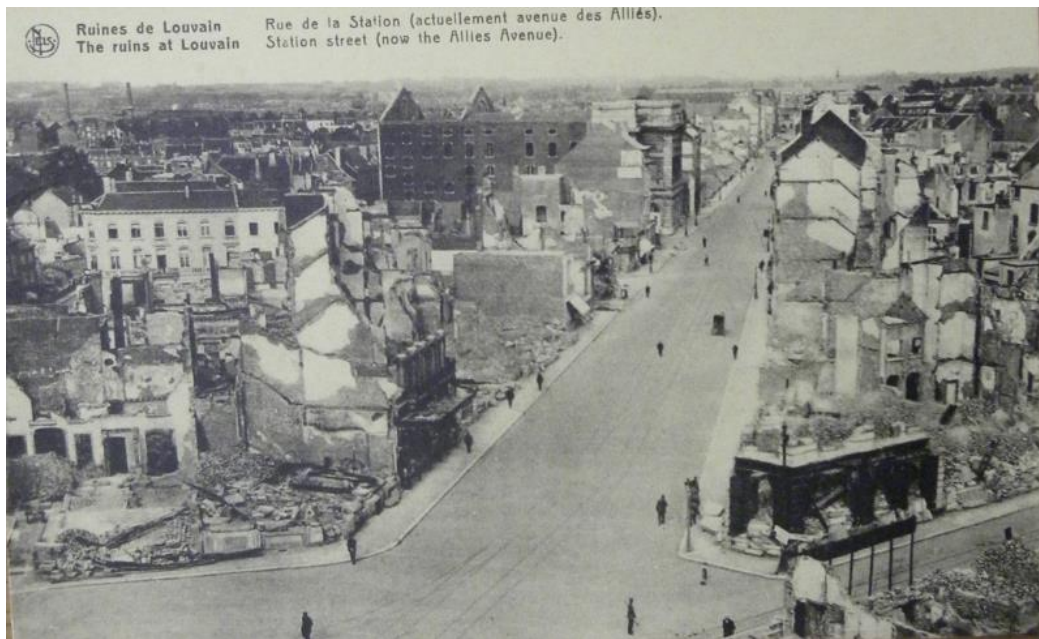
Figuur 12. Zicht op de oorlogsschade aan de Statiestraat 14 .
