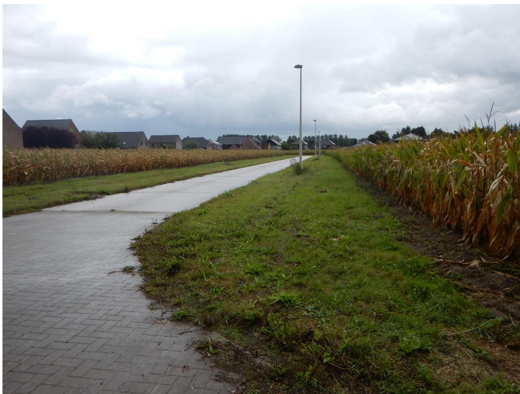
Figuur 4: Bestaande toestand
