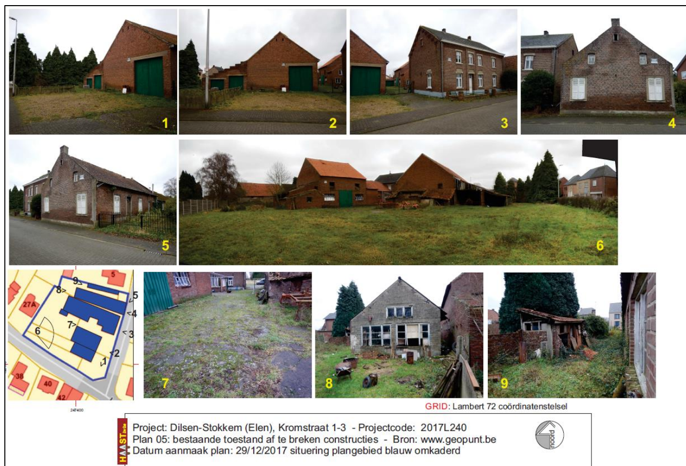
Fig. 6: Overzicht van de bestaande, te slopen en op te breken toestand.
