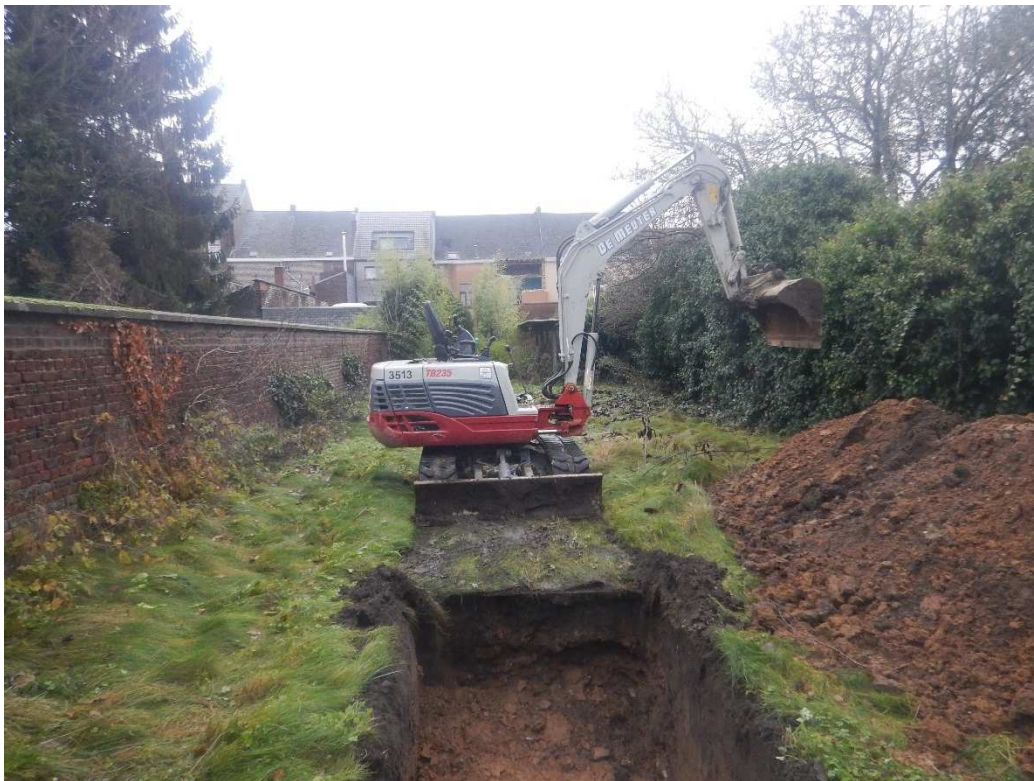
Foto 3: Zicht op het noordoostelijk deel van de tuin, ter hoogte van werkput 3 (op de voorgrond). Foto richting oosten, in de richting van de Lessensestraat. (©BAAC Vlaanderen)
