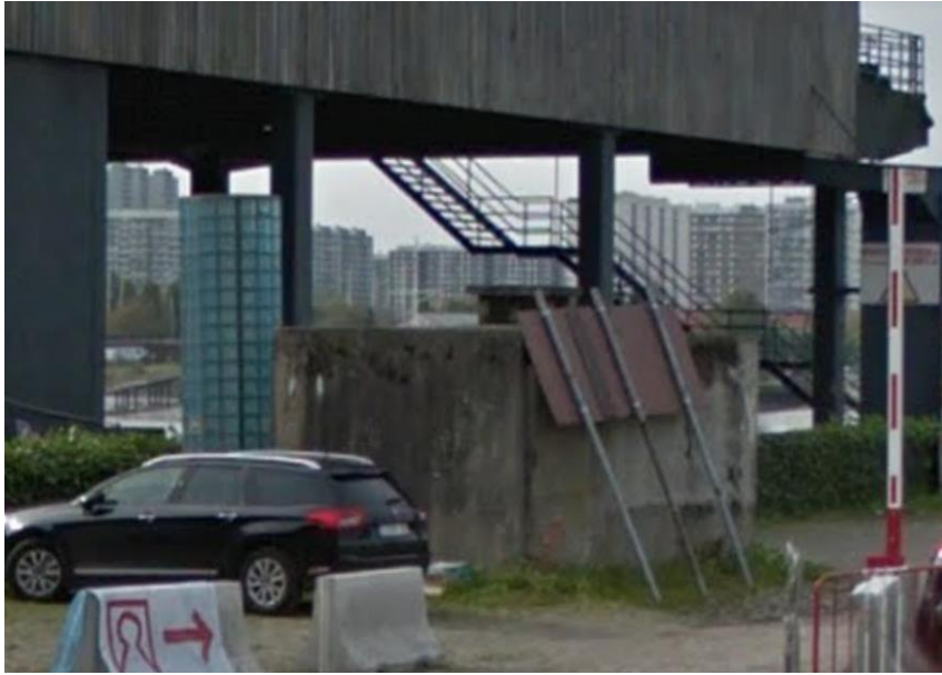
Figuur 23: Atoombunker ten noorden van Hangar 26-27.
