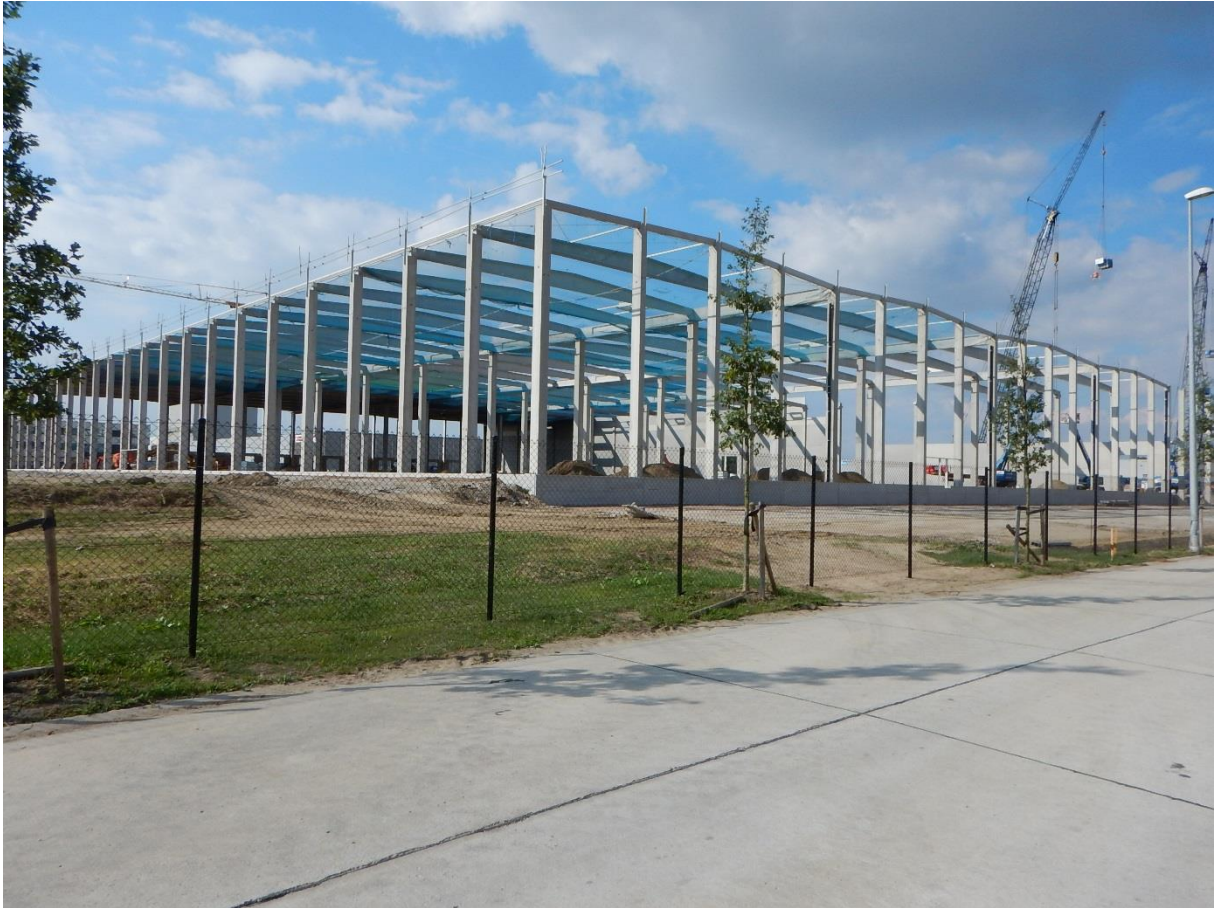
Figuur 3: Foto van de werf in uitvoering
