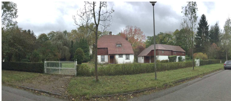
Figuur 5: Zicht op de voormalige bebouwing aan Lentelaan 8 (Deneef, 23/10/2017)
