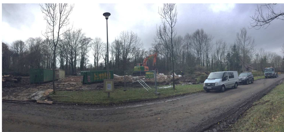
Figuur 6: Zicht op de sloopwerken, huidige situatie (Deneef, 7/12/2017)
