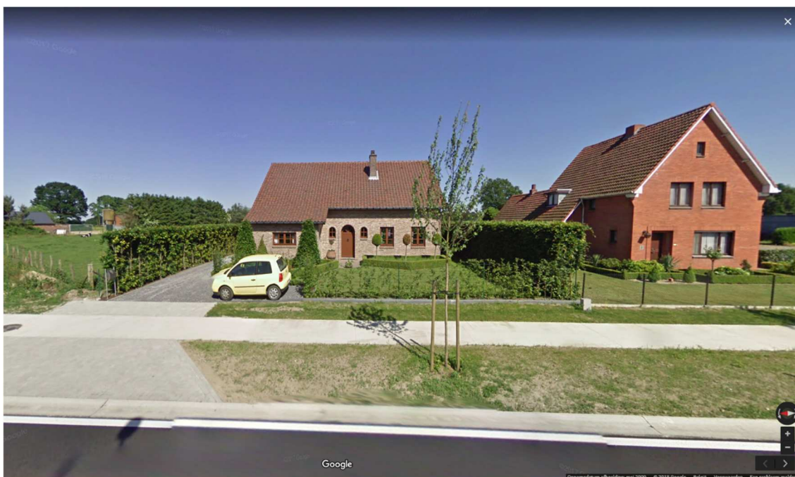
Figuur 5: Het onderzoeksgebied gezien vanaf W-O richting, midden (Google Street View, 2009)
