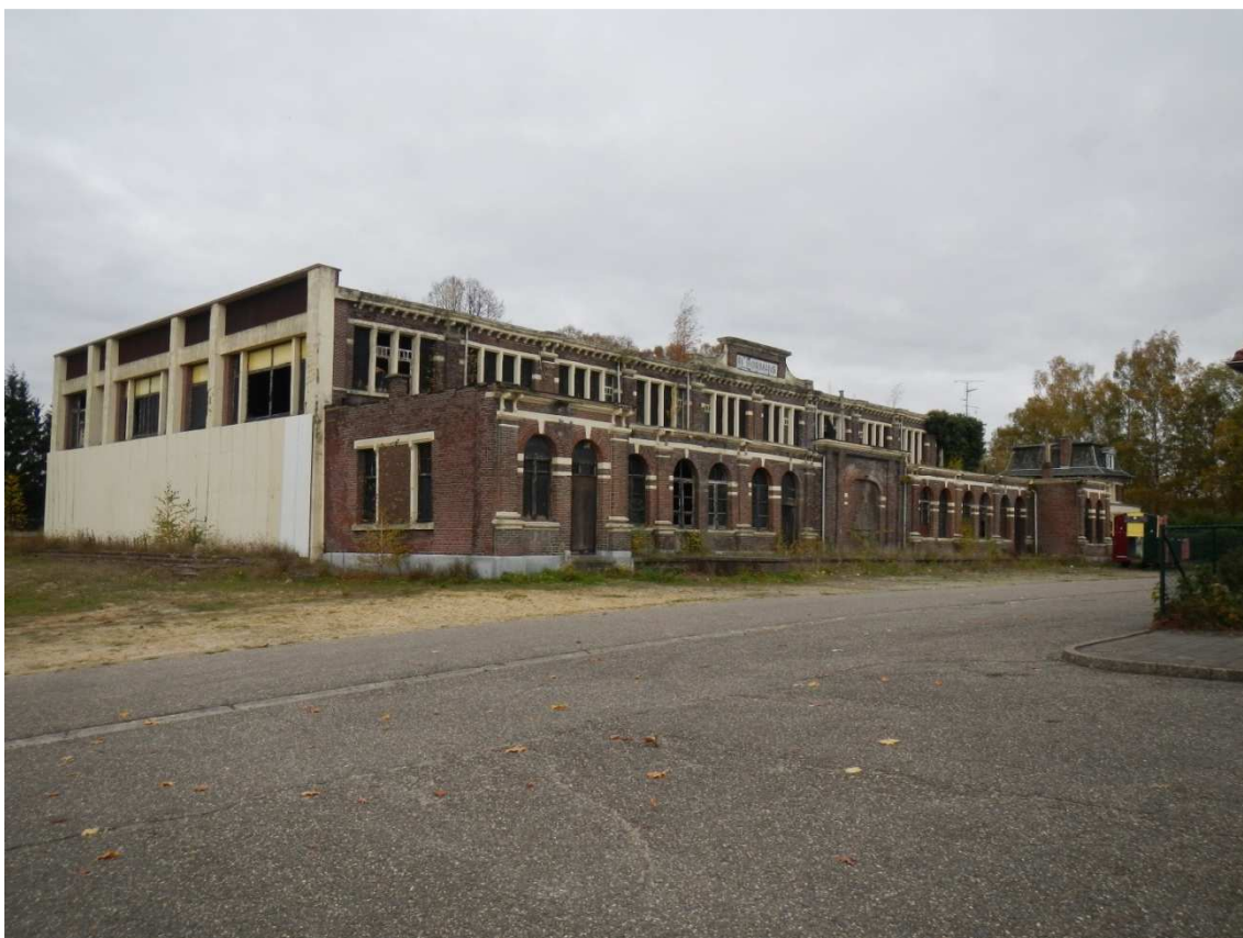
Figuur 6: Huidige toestand van het gebouw (IOE, 2015)
