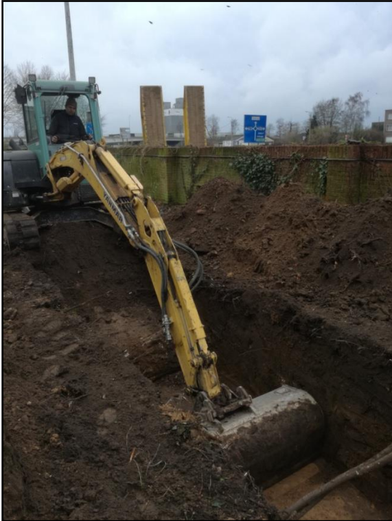
Figuur 5 Foto tijdens de aanleg van de sleuven.
