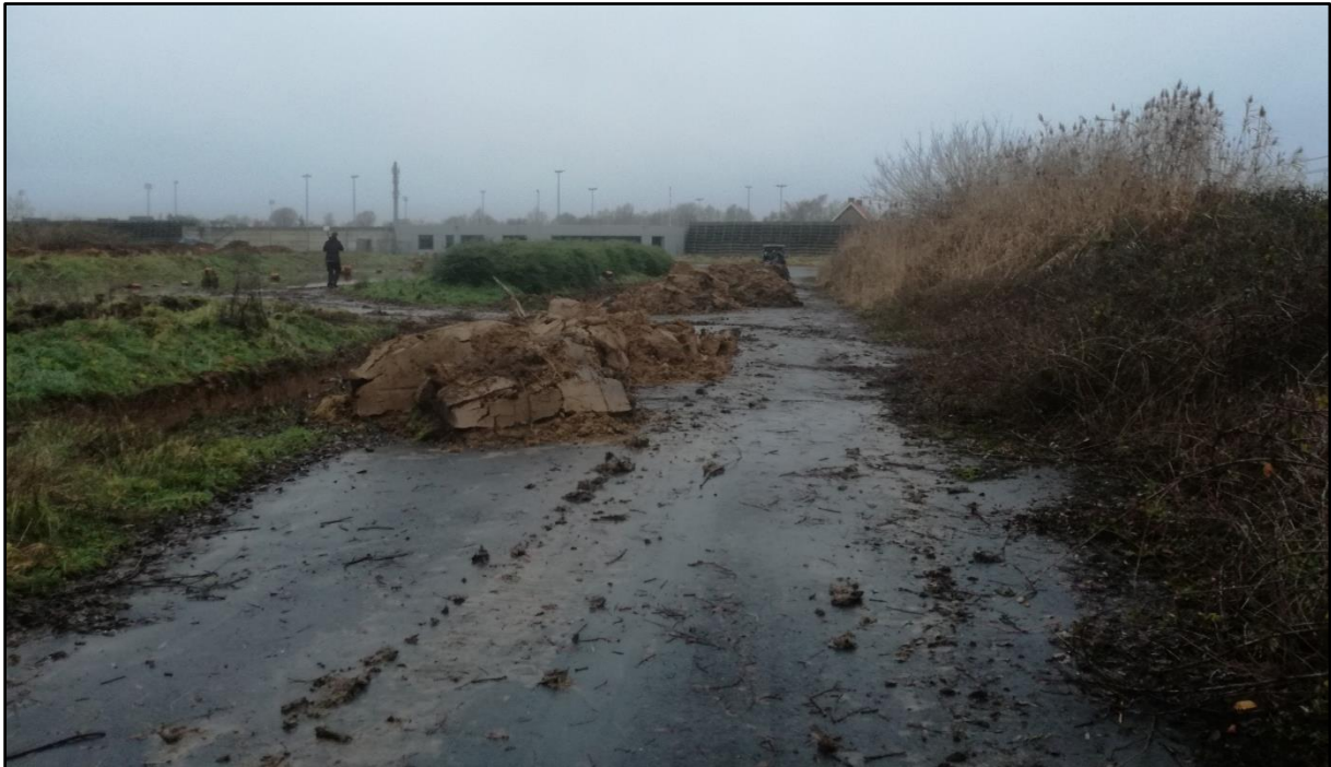
Figuur 3 Zicht op het plangebied in het noordoosten met de omwalling aan de straatzijde. Voor de aanleg van de omwalling werd grond gebruikt die weggegraven werd voor de aanleg van de weg. Deze weg ligt beduidend lager dan het westelijke deel.
