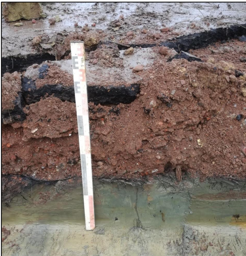
Figuur 4 Zicht op de funderingswijze van de asfaltwegen (asfalt en compact steenslag).
