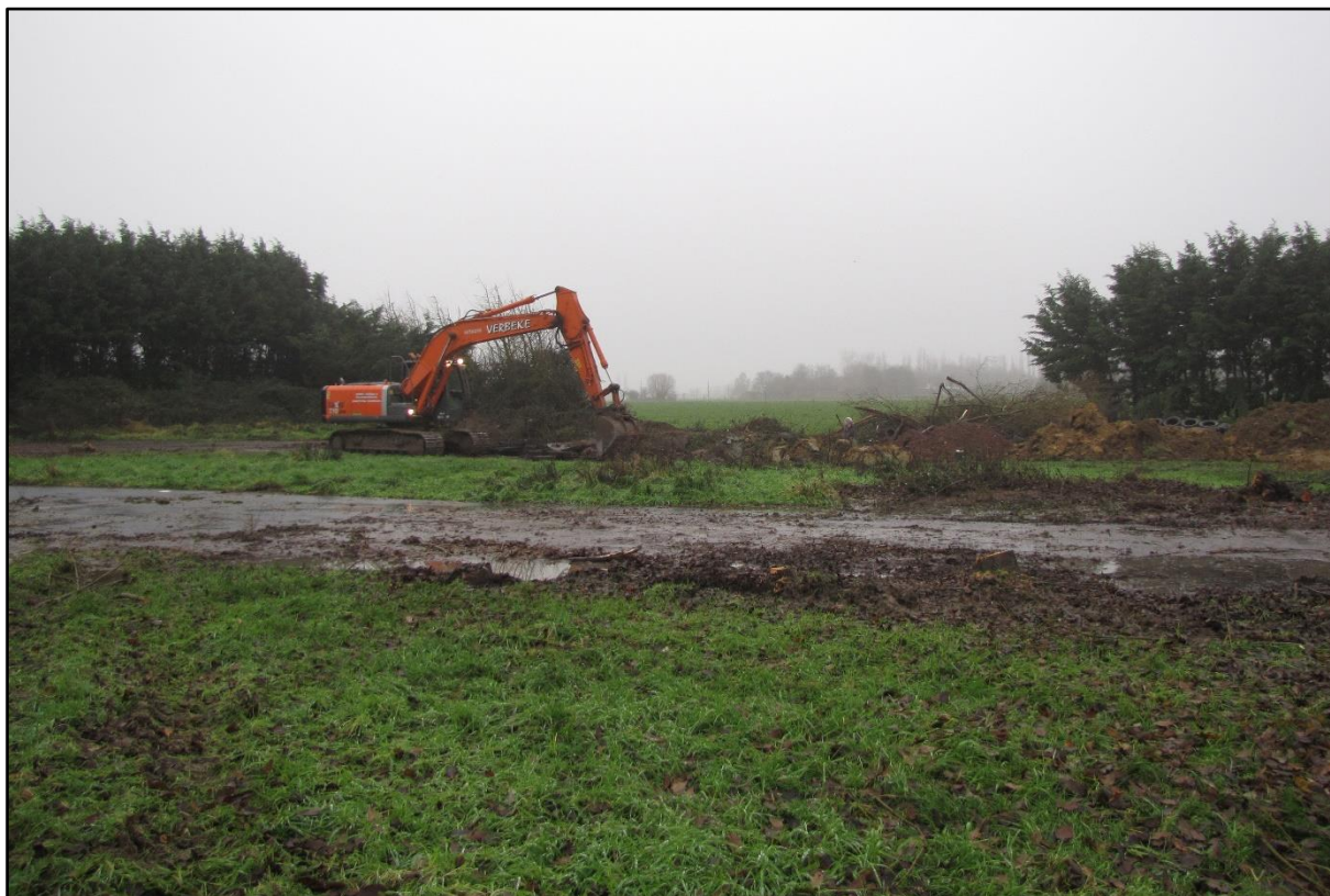
Figuur 8 Aanleg van de proefsleuven.
