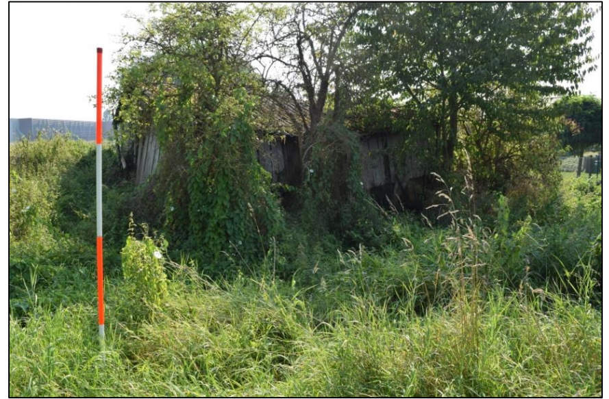
FOTO 48: Zicht op aanwezige vervallen bebouwing (beschuttingsplaats) op deelgebied 1. Foto genomen uit het oosten, (Aron bvba, dd. 26/08/2016)
