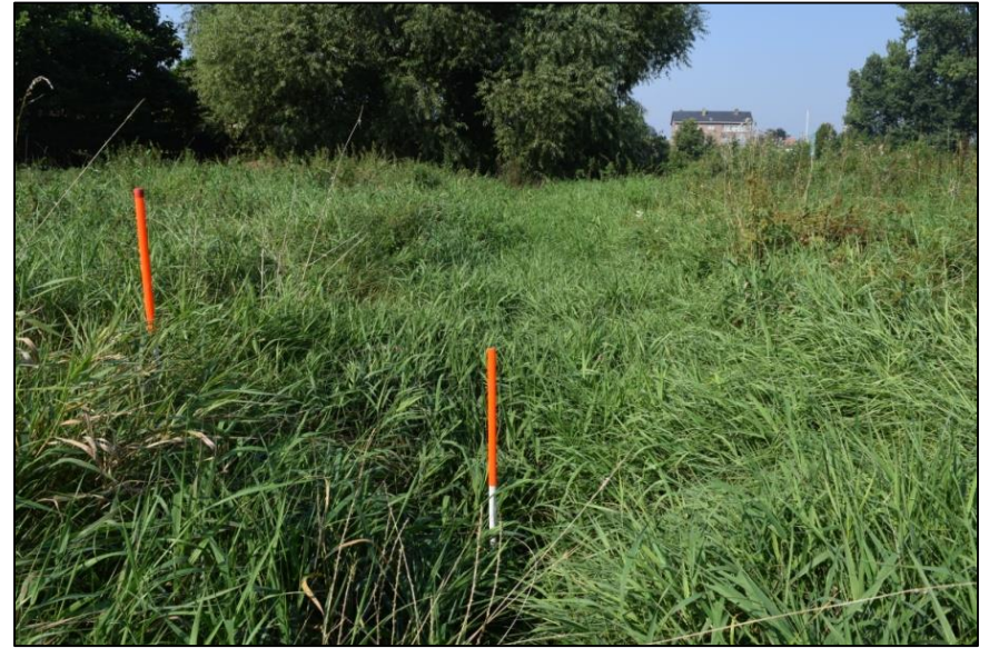
FOTO 50: Zicht op zuidelijke afwateringsgreppel op deelgebied 1 (jalon rechts), overwoekerd met gras. Foto genomen uit het oosten, (Aron bvba, dd. 26/08/2016)
