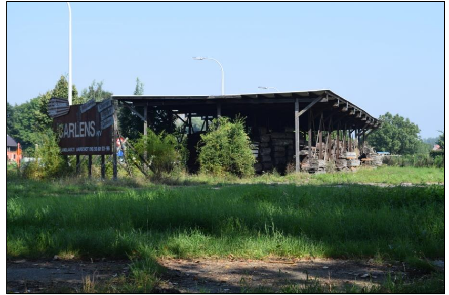
FOTO 38: Zicht op de houthandel in de noordwestelijke hoek van het terrein. Foto genomen uit het zuidoosten, (Aron bvba, dd. 26/08/2016)
