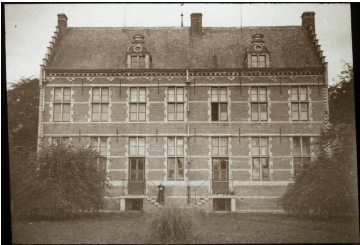
Figuur 36: Foto (voor 1964) van de achterkant van het kasteel (Erfgoedbank Noorderkempen)
