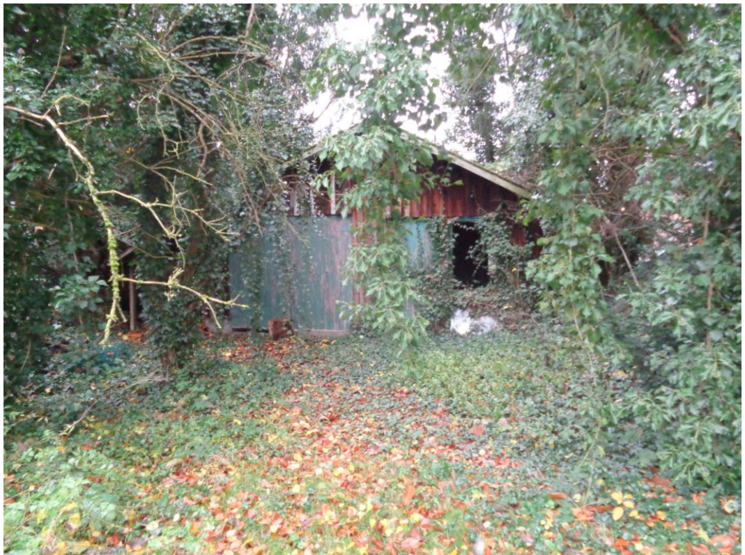
Afb. 12. Houten schuur: detail 1.
