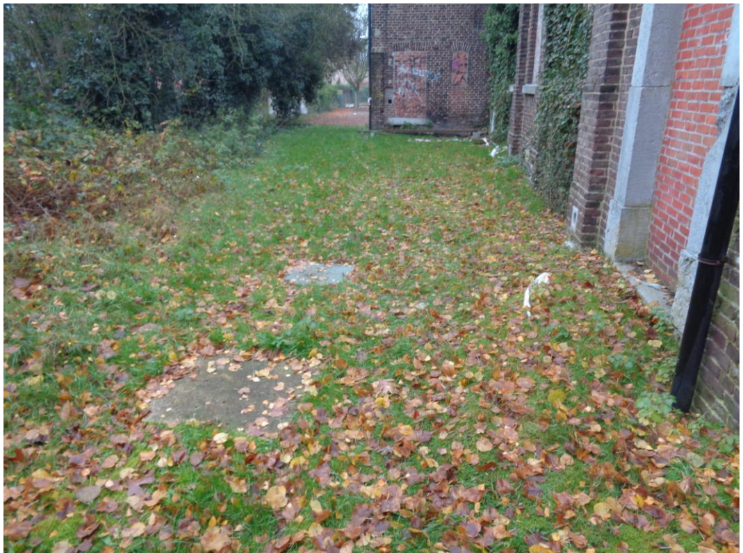
Afb. 8. Zijkant schoolgebouw: detail 1.
