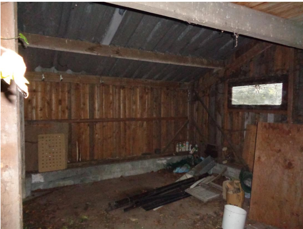
Afb. 14. Houten schuur: detail 3.
