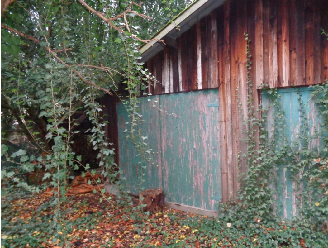
Afb. 13. Houten schuur: detail 2.
