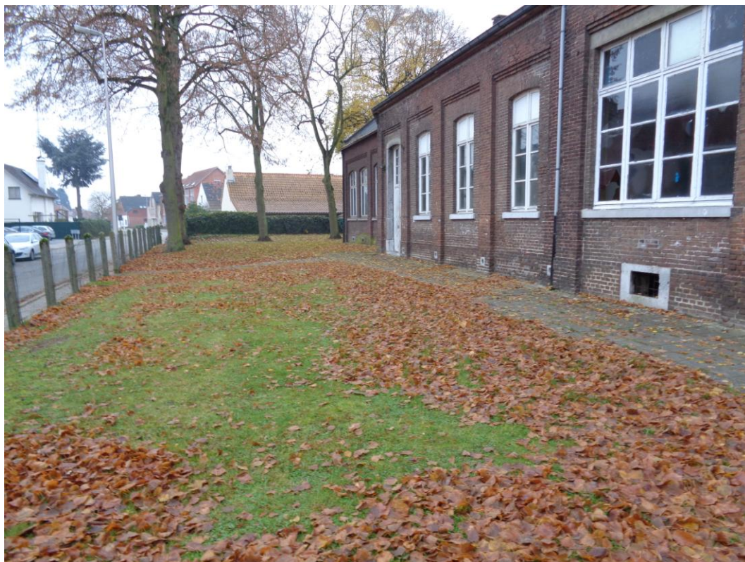
Afb. 9. Zijkant schoolgebouw: detail 1.
