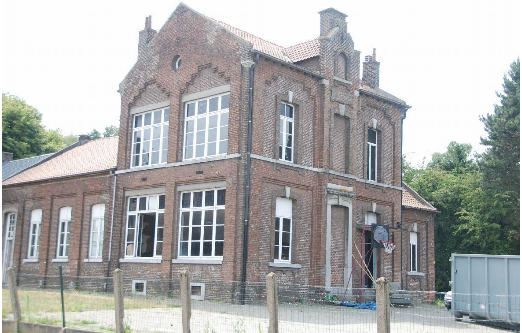
Afb. 7. Voorkant schoolgebouw: detail 3.
