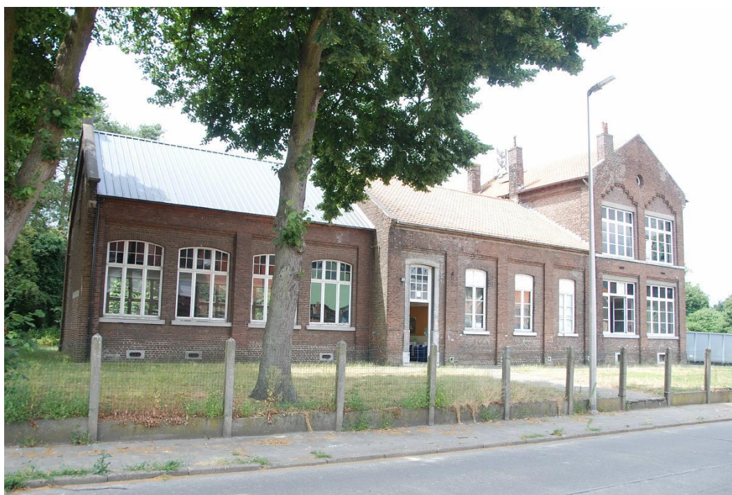
Afb. 6. Voorkant schoolgebouw: detail 2.
