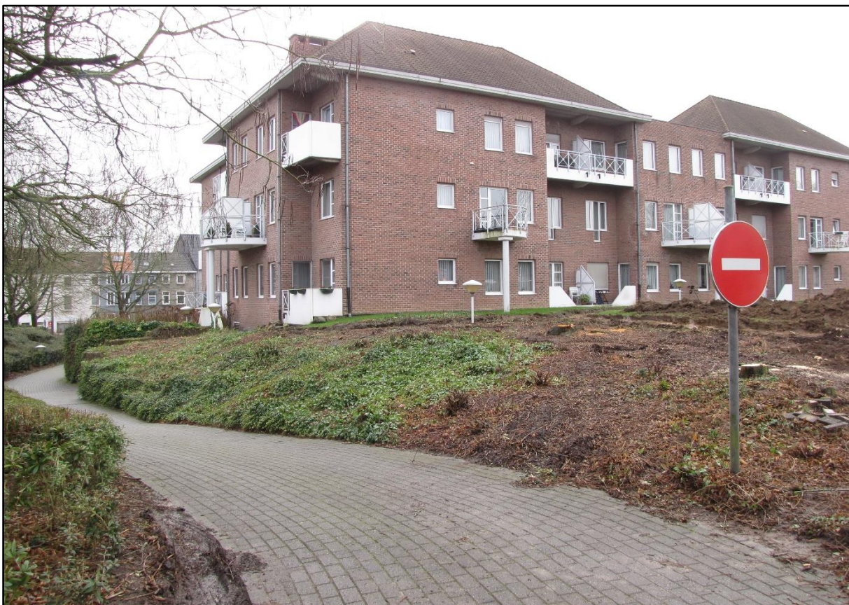
Figuur 4 Zicht op de bestaande op- en afrit voor het OCMW die beduidend dieper gelegen is.
