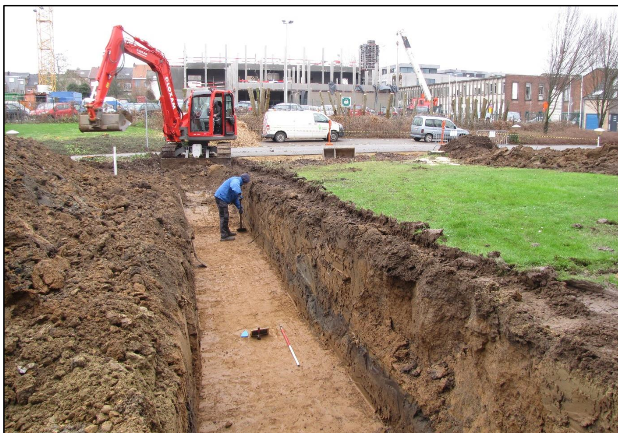
Figuur 8 Overzichtsfoto tijdens de aanleg van de sleuven.
