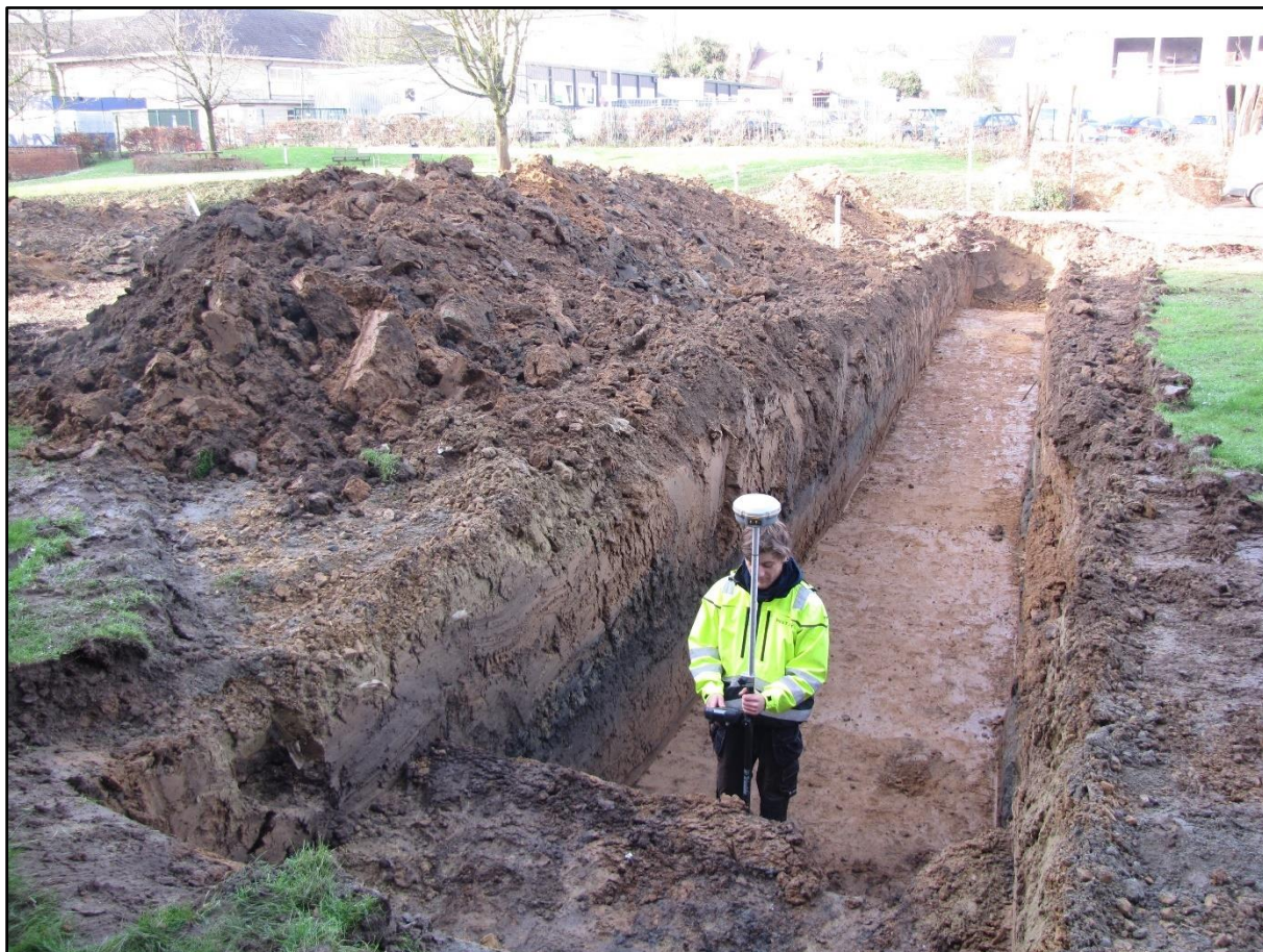
Figuur 11 Opmeting van de proefsleuven.
