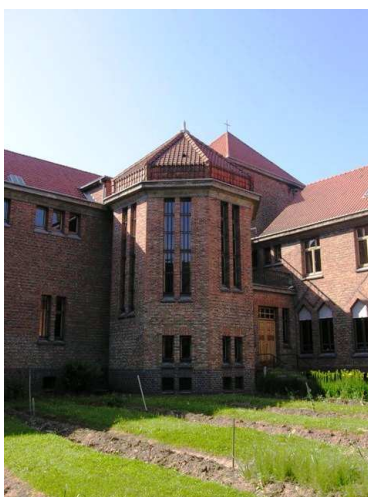
Figuur 7: Detail buitengevel traptoren (AOE, 2010)
