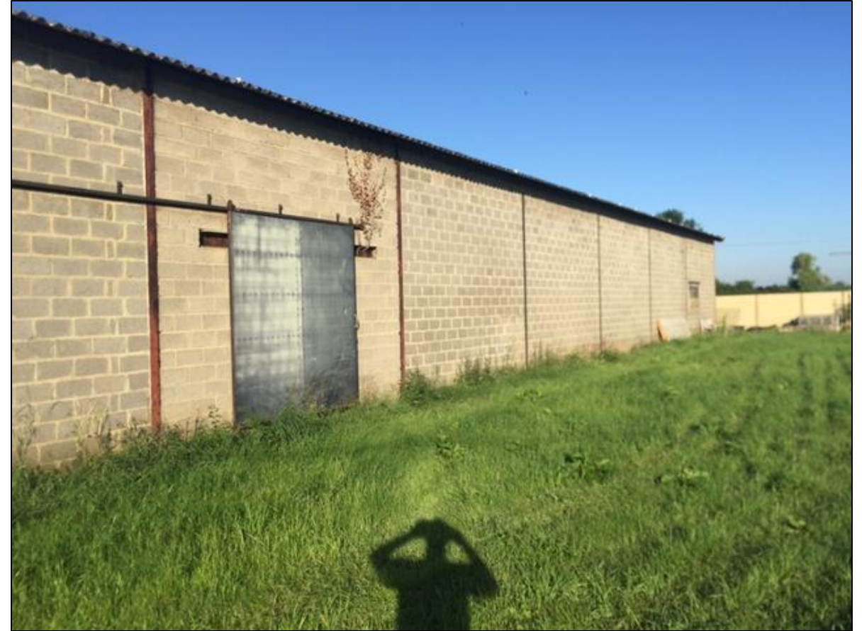
Foto 4: Zicht op de te verbouwen loods op het onderzoeksterrein. Foto genomen vanuit het noordoosten. (Bron: R2Livin Architects bvba, dd 02/08/2017, 2017H23)
