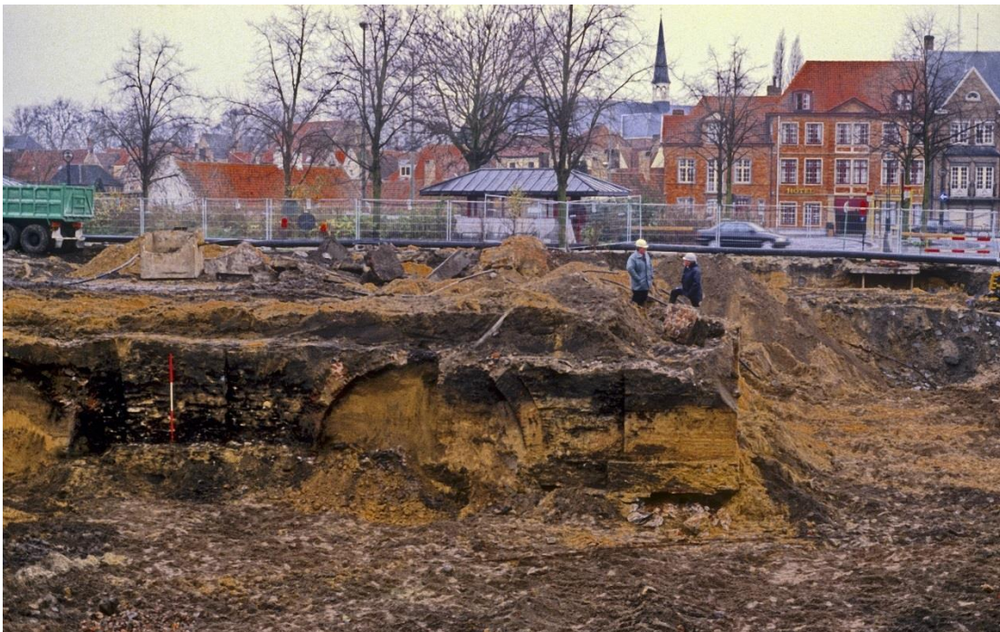
Figuur 15: zicht op de funderingen van de 19 de eeuwse goederenloods (bron: dia-collectie Raakvlak)
