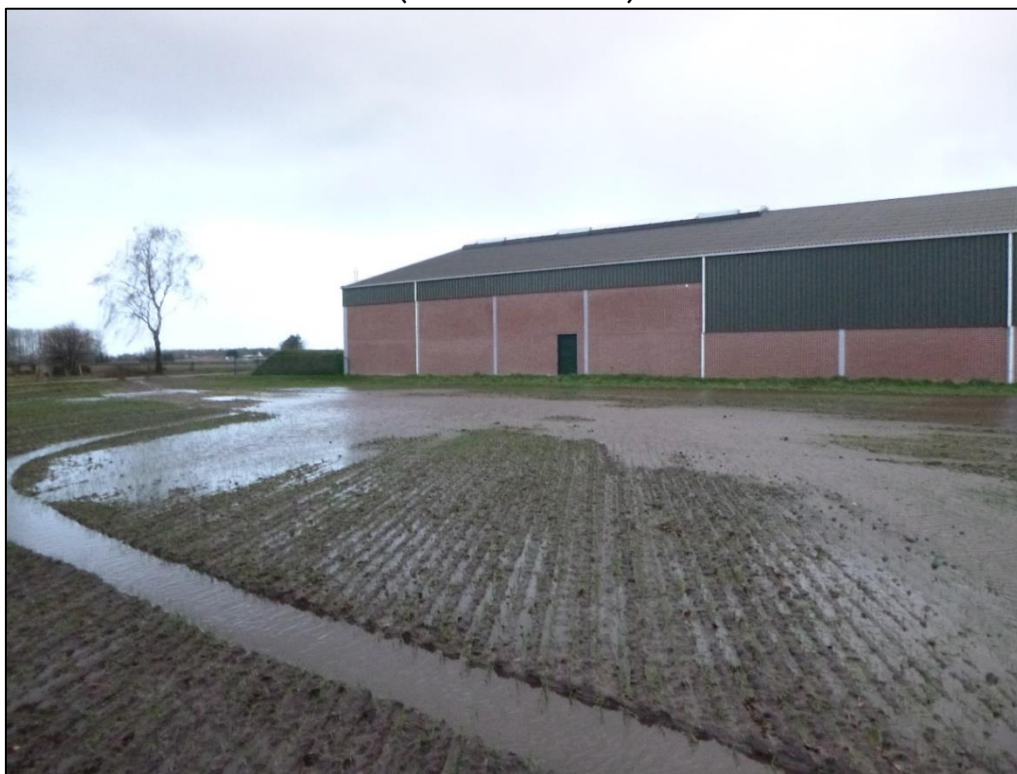
Figuur 43: Foto zuidelijk deel van het terrein, ten oosten van de bestaande loods. (Bron: ABO nv 2018)
