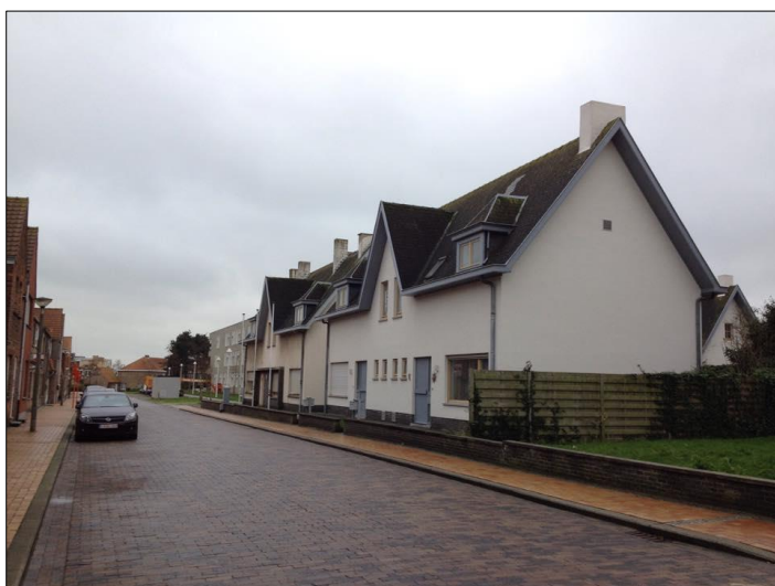
Figuur 3: Te slopen huizen aan de Rijkswachtstraat.
