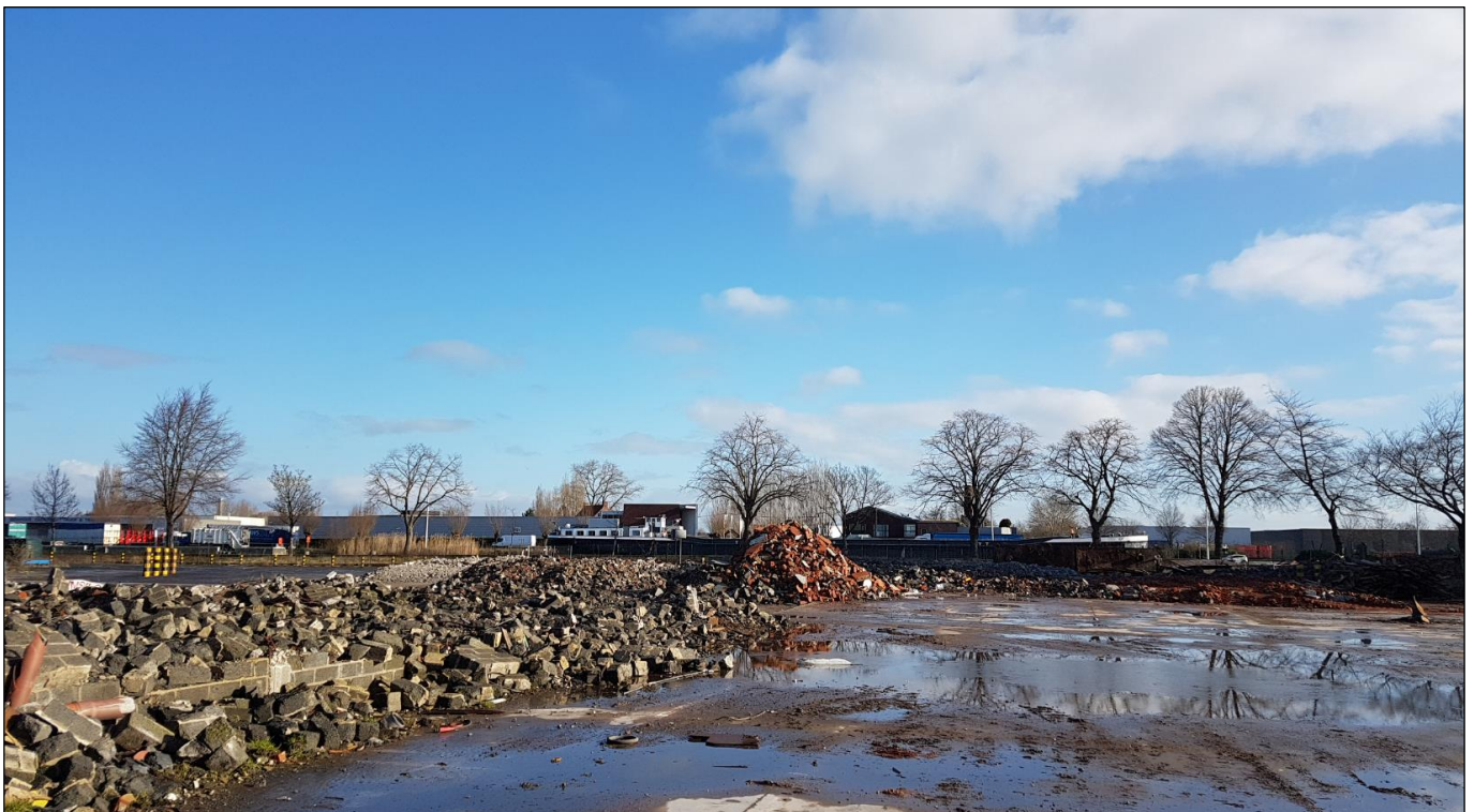
Figuur 5: Foto's huidige sloop (bron: opdrachtgever).
