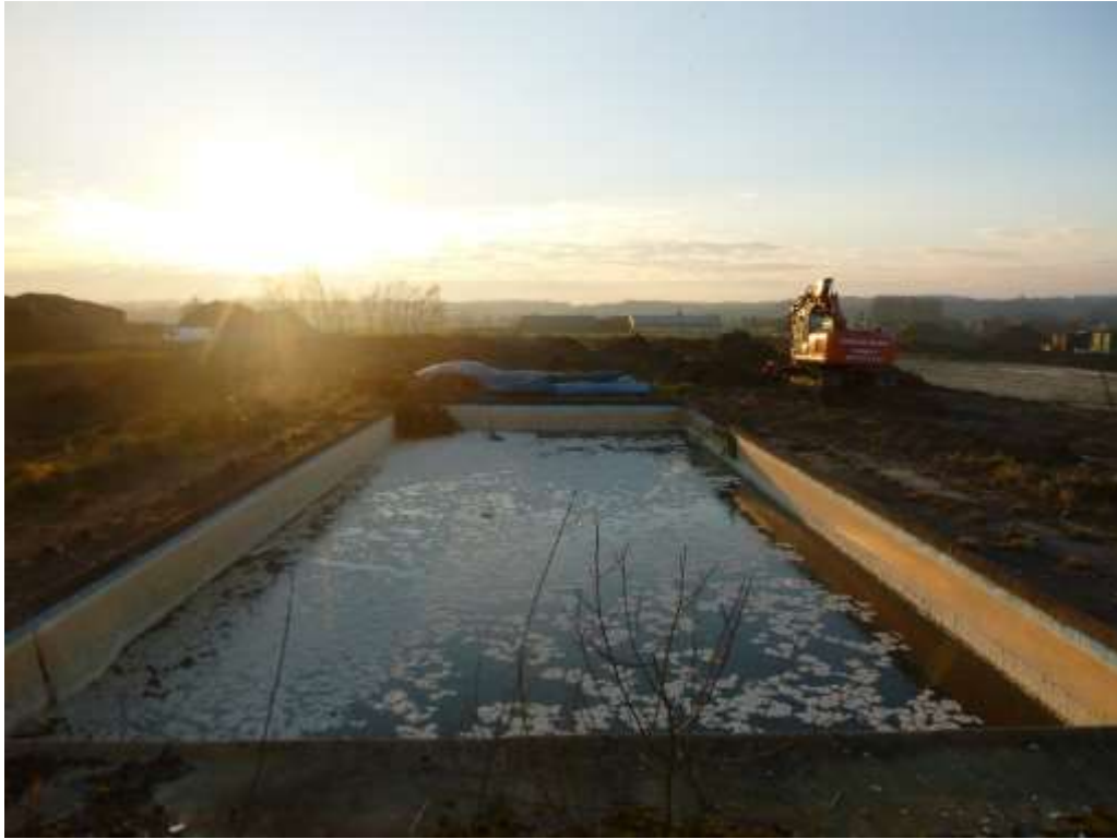
Figuur 7: Sfeerfoto genomen vanop het terras van de te slopen villa met zicht op het zwembad en de zuidelijke helft van het plangebied
