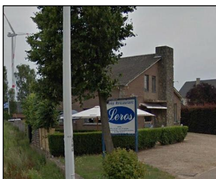
Fig. 10: Overzicht van de bestaande toestand en te slopen woningen: 180° panorama van het terrein, de af te breken woningen, het veld.
