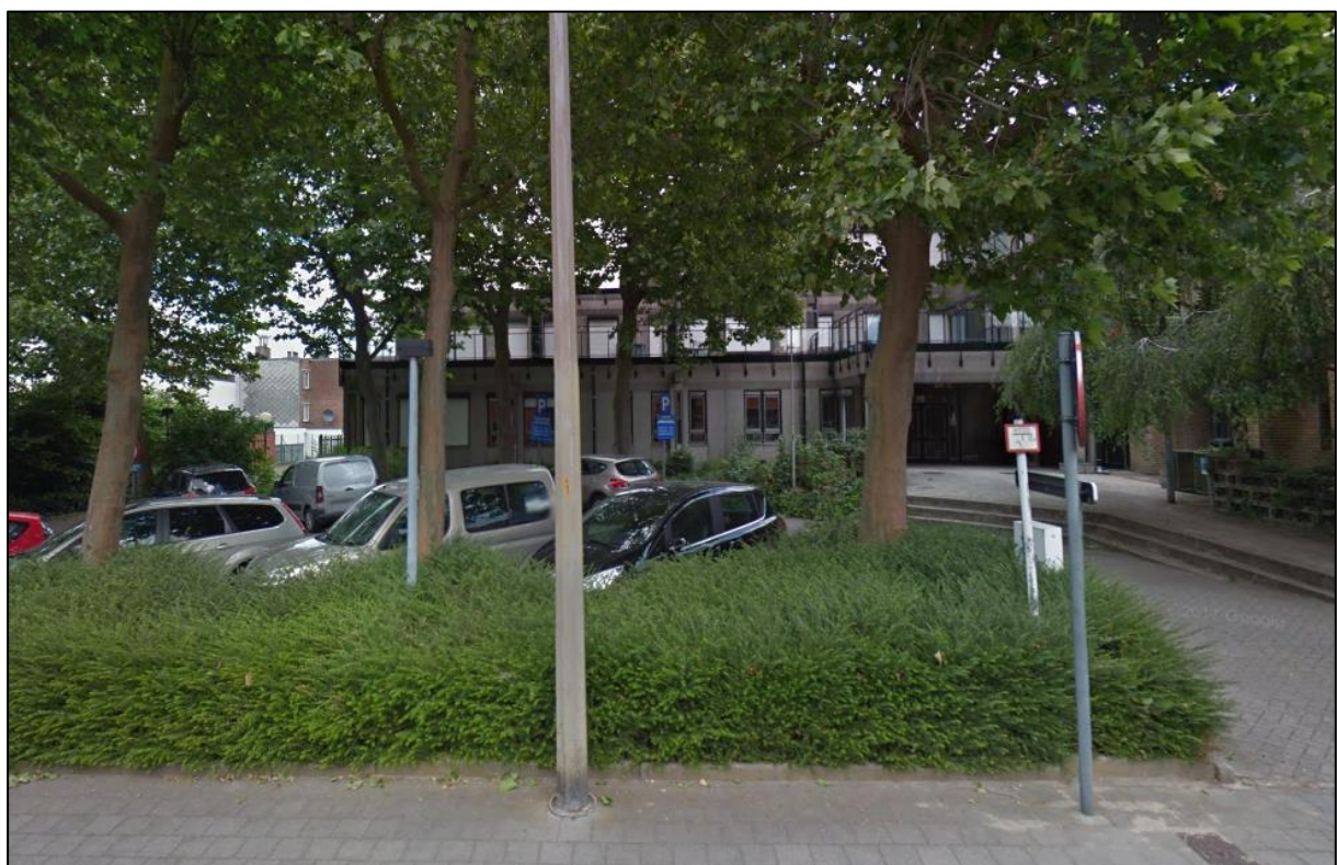
Figuur 4: Foto van de bebouwing op het studiegebied (Google Streetview 2018)
