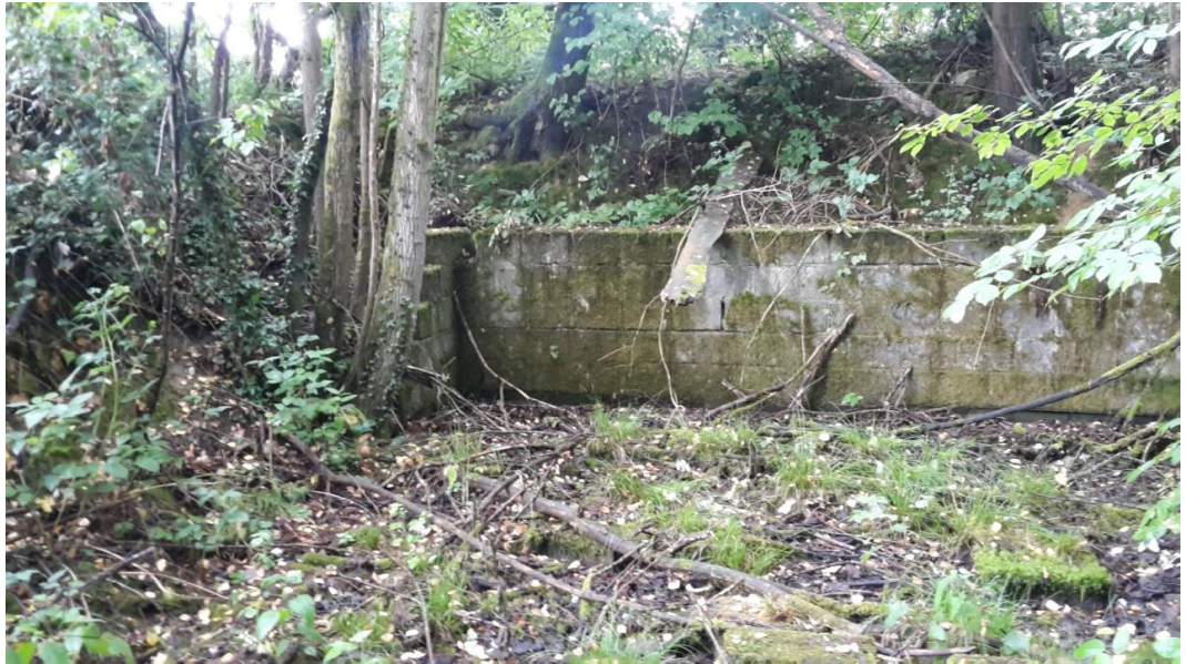
Afb. 10. Detailfoto van de kelder.
