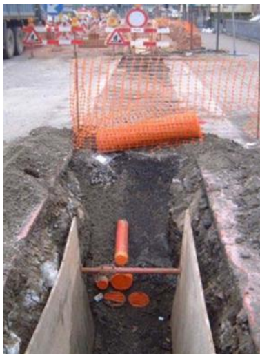
Figuur Fout! Geen tekst met de opgegeven stijl in het document.-3: Voorbeeld van een type B-sleuf voor wegkruisingen
