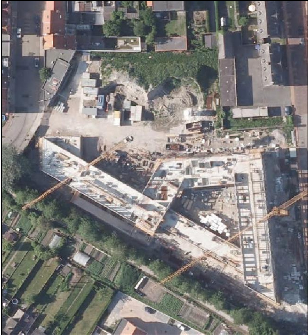
Figuur 32: Luchtfoto tijdens de bouw van het nieuwe woon- en zorgcentrum "De Zathe" in 2012 (Bron: Antea Group 2014)
