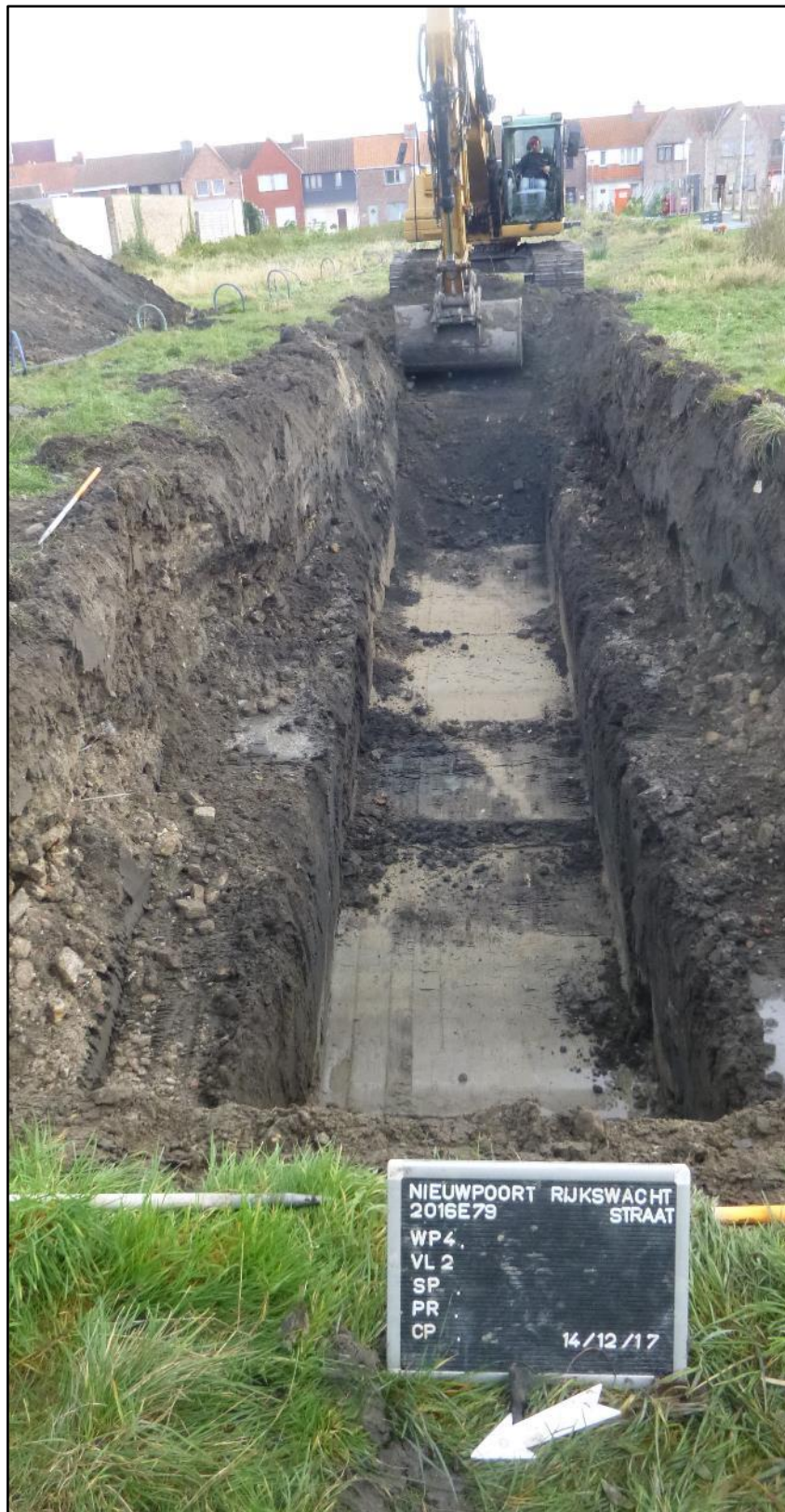
Figuur 63: Algemeen zicht op de aanleg van Werkput 4
