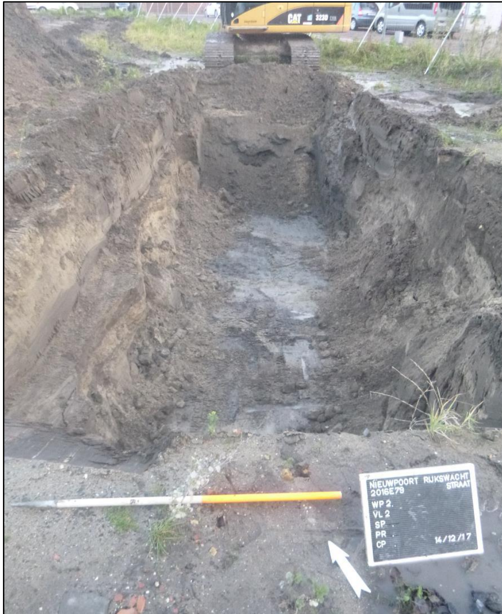
Figuur 55: Onveilige situatie tijdens de aanleg van Werkput 2
